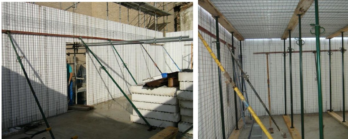
Figura 8. Aplomado de muros y apuntalamiento, adaptado obra civil llanos orientales
