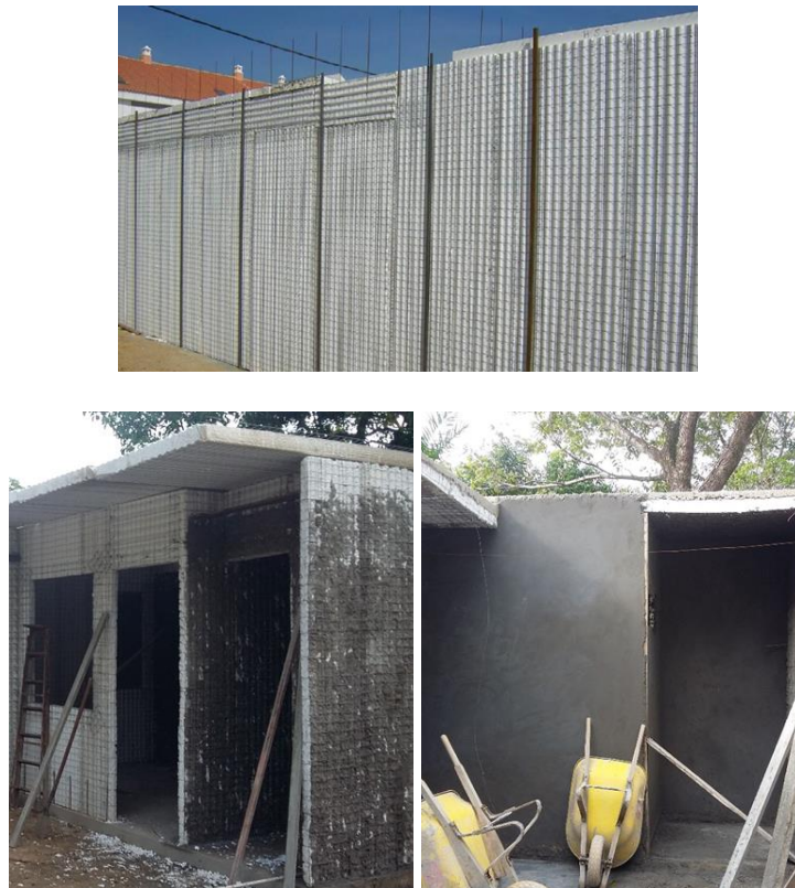
Figura 10. Aplicación del mortero, adaptado obra civil llanos orientales.
