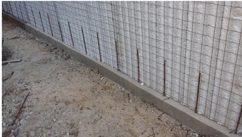
Figura 7. Colocación de Anclajes, adaptado obra civil llanos orientales
