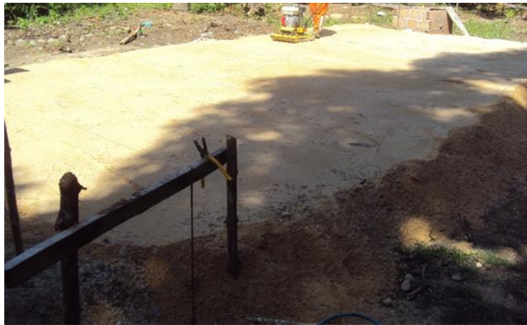
Figura 3. Nivelación del terreno, adaptado obra civil llanos orientales
