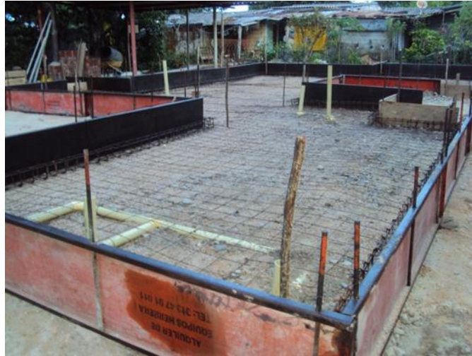
Figura 5. Encofrado, adaptado obra civil llanos orientales
