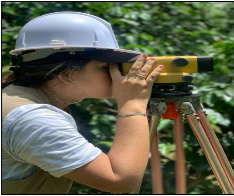
Figura 6. Levantamiento topográfico de las estructuras del acueducto.
