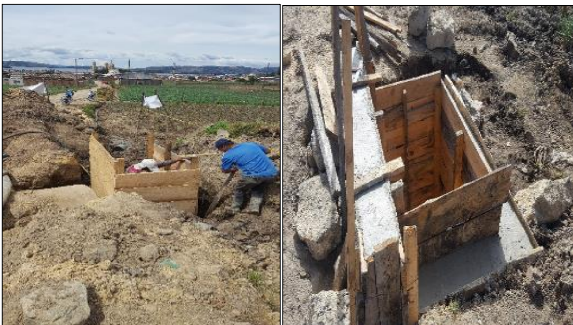
Fotografía 39: Formaleta para fundida de cabezotes de alcantarilla ubicada en el KM0+000.
