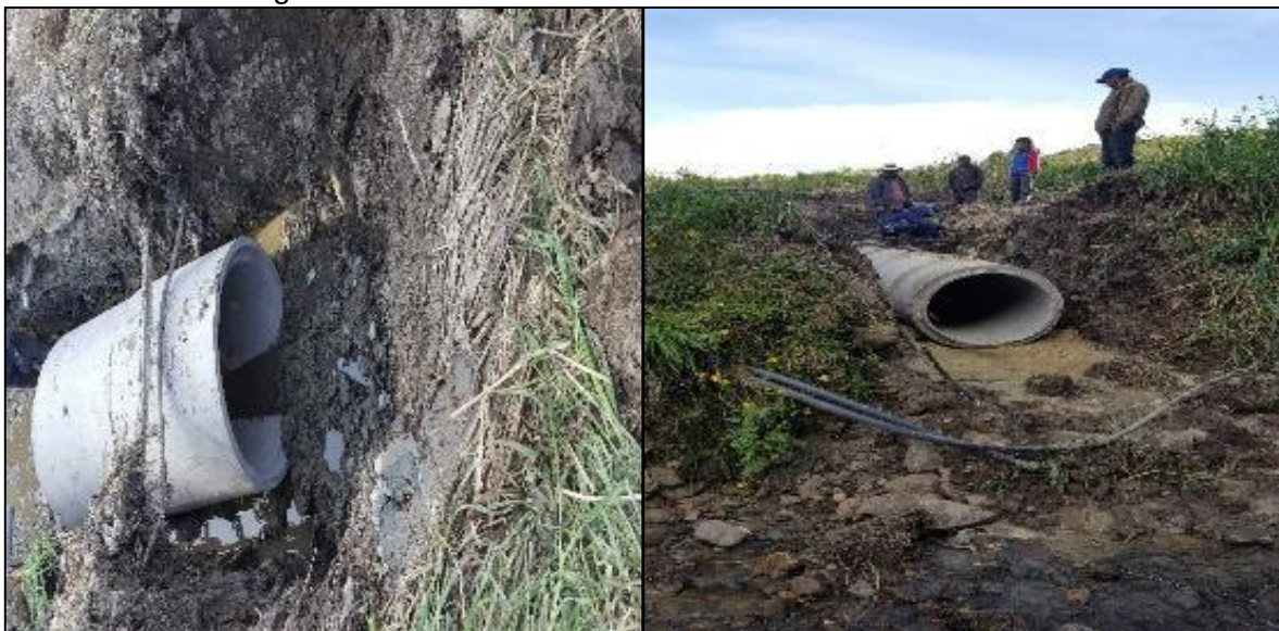
Fotografía 37: Instalación tubería 36" alcantarilla KM 1 + 100.
