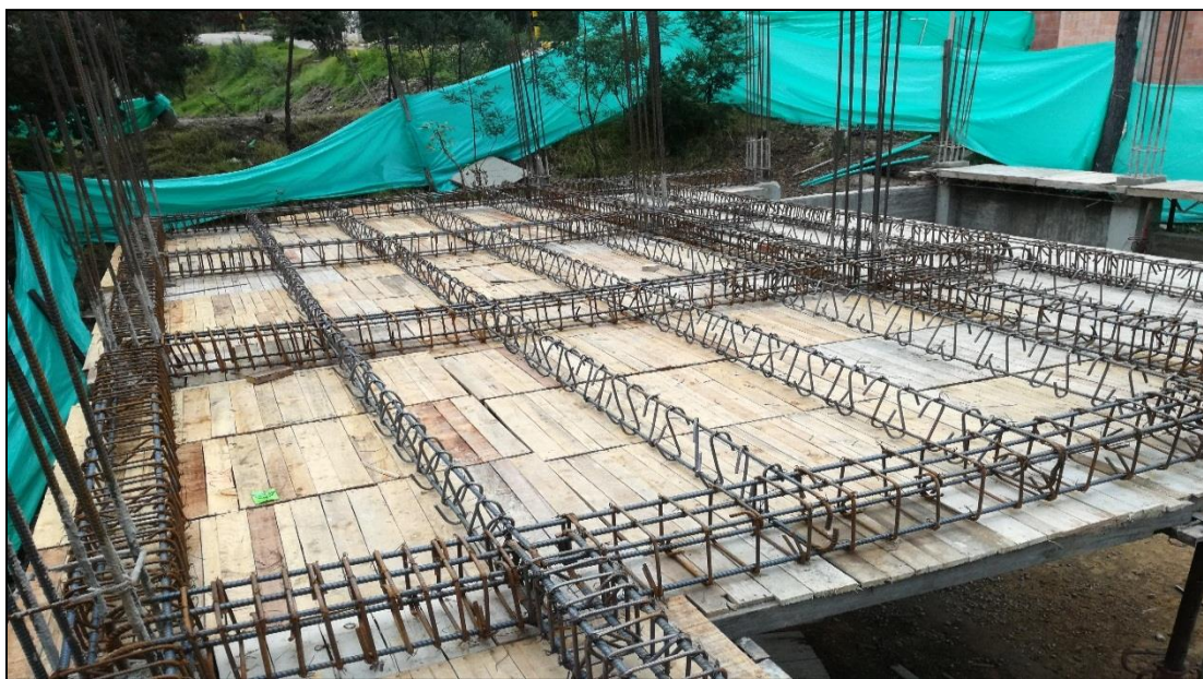
Fotografía 22: Refuerzo longitudinal acero de refuerzo placa entrepiso.
