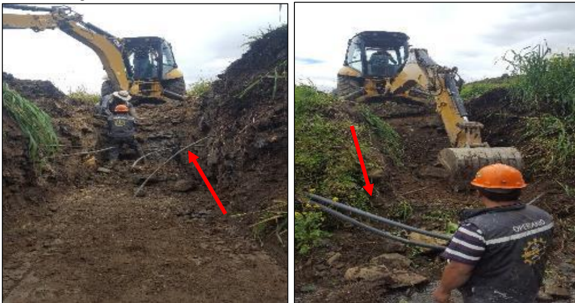
Fotografía 33: Excavación mecánica, alcantarilla ubicada en el KM 1 + 100.
