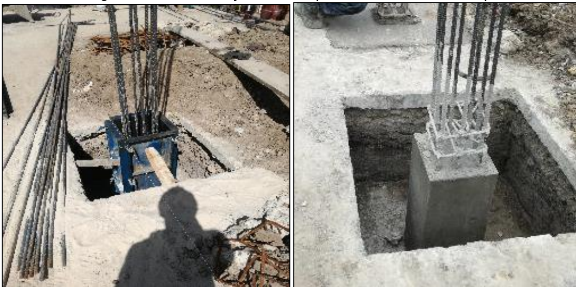
Fotografía 12: Formaleta y fundida de pedestales concreto 3000 psi.
