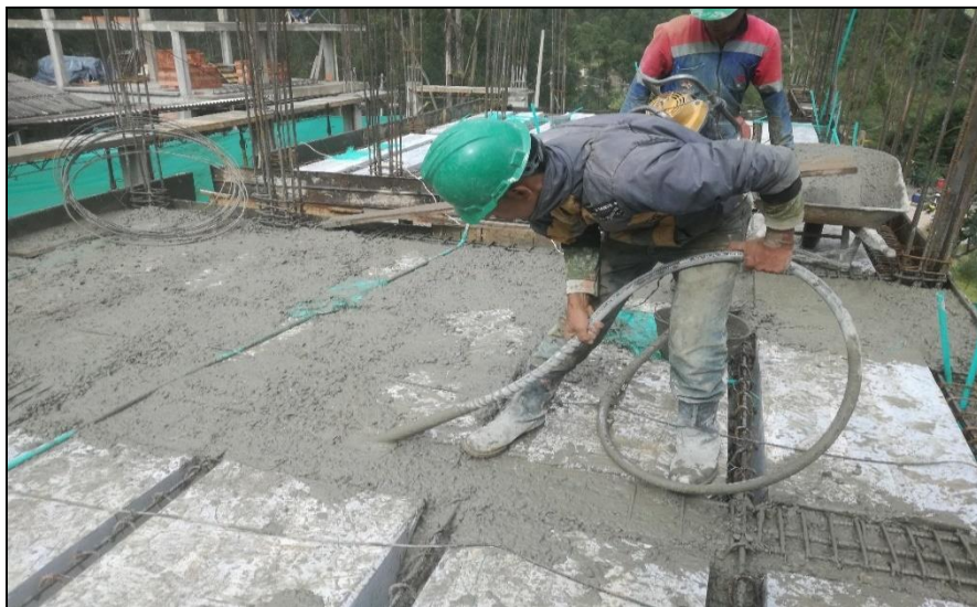
Fotografía 24: Vaciado y vibrado del concreto placa entrepiso.
