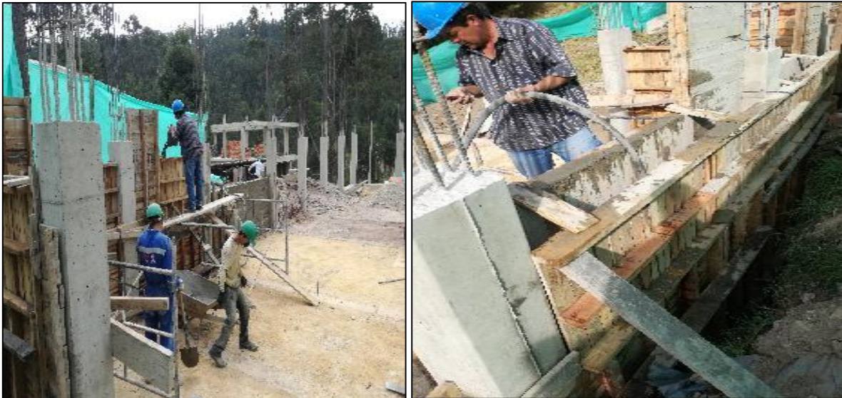
Fotografía 20: Vaciado y vibrado del concreto muro de contención.
