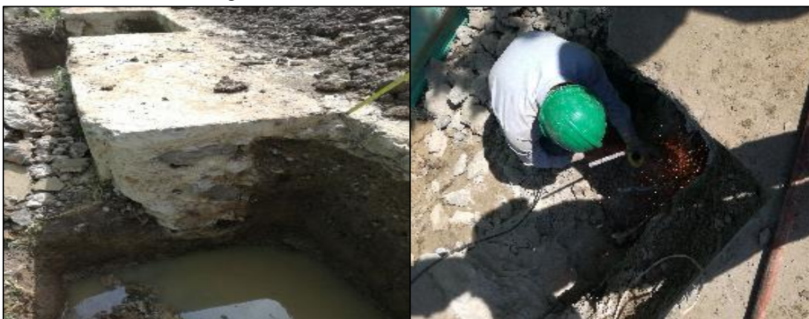
Fotografía 4: Cortes acero en concreto reforzado.
