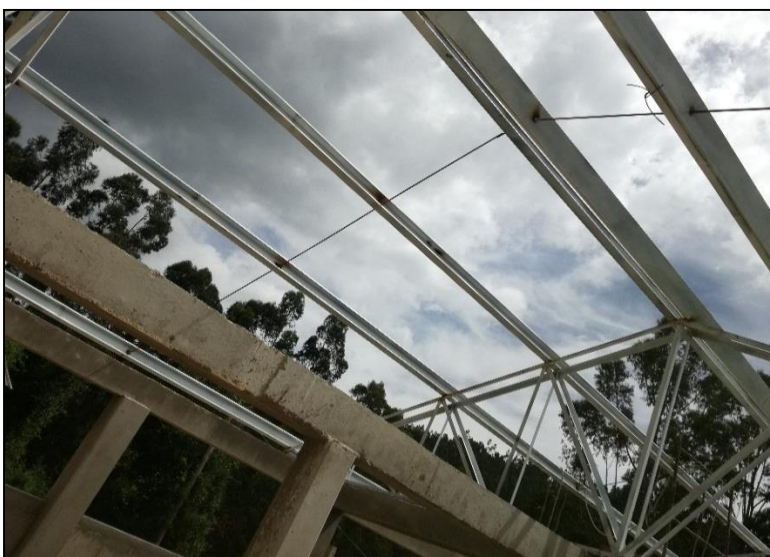
Fotografía 30: correas y templete estructura metálica.
