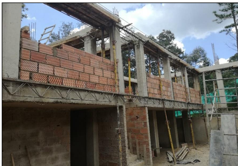
Fotografía 25: muros internos en bloque #5.
