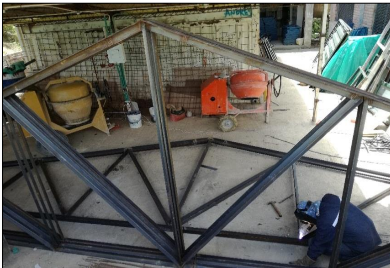
Fotografía 29: Cercha metálica de cubierta.
