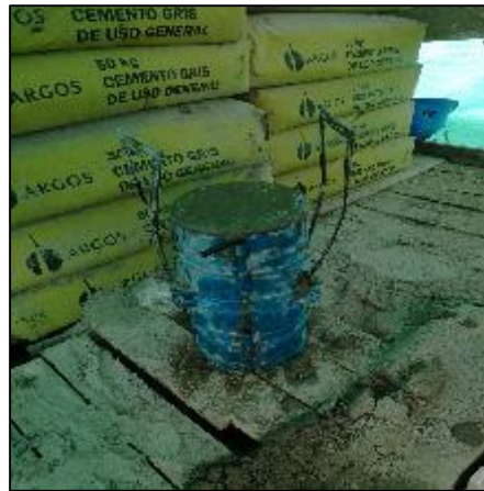
Fotografía 11. Toma de muestras ensayos de concreto.
