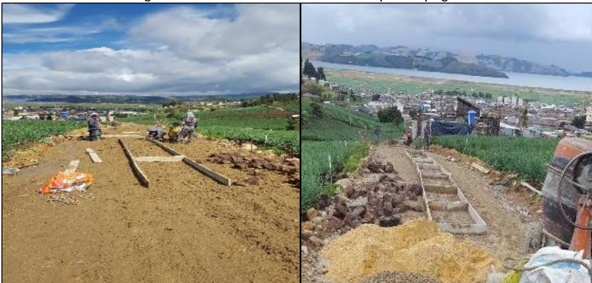
Fotografía 50: Armado de formaletas de piedra pegada.
