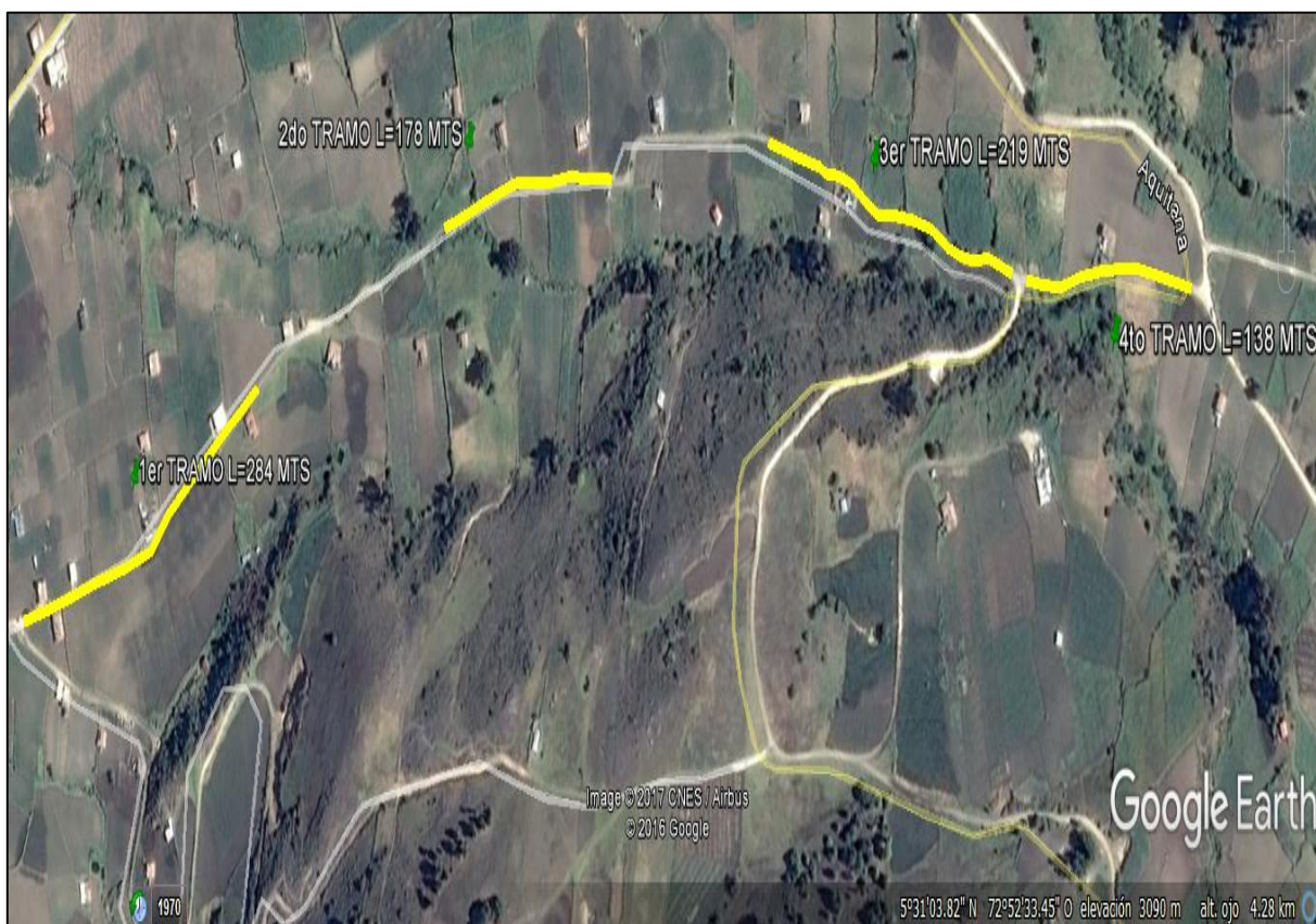
Figura 14: Longitud tramos construidos placa huella.
