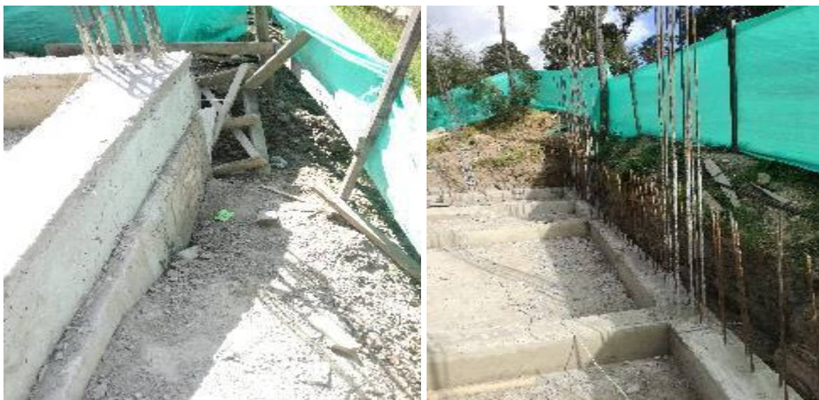
Fotografía 13: Fundida vigas de cimentación.
