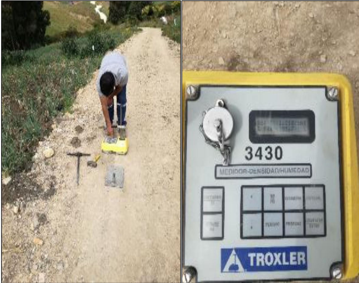
Fotografía 48: Toma de densidades con densímetro nuclear.
