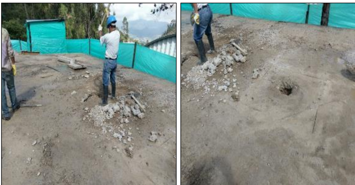
Fotografía 1: Corte Y Demolición Placa Existente.
