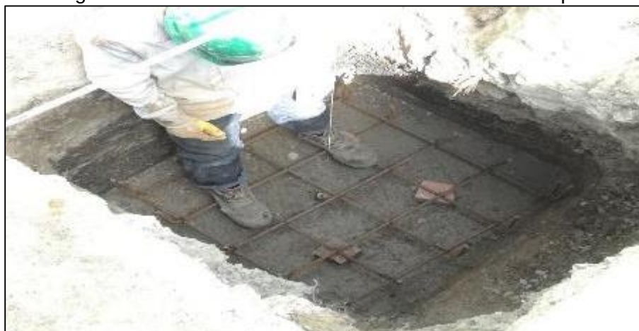
Fotografía 8: Acero de refuerzo de las canastas de las zapatas.
