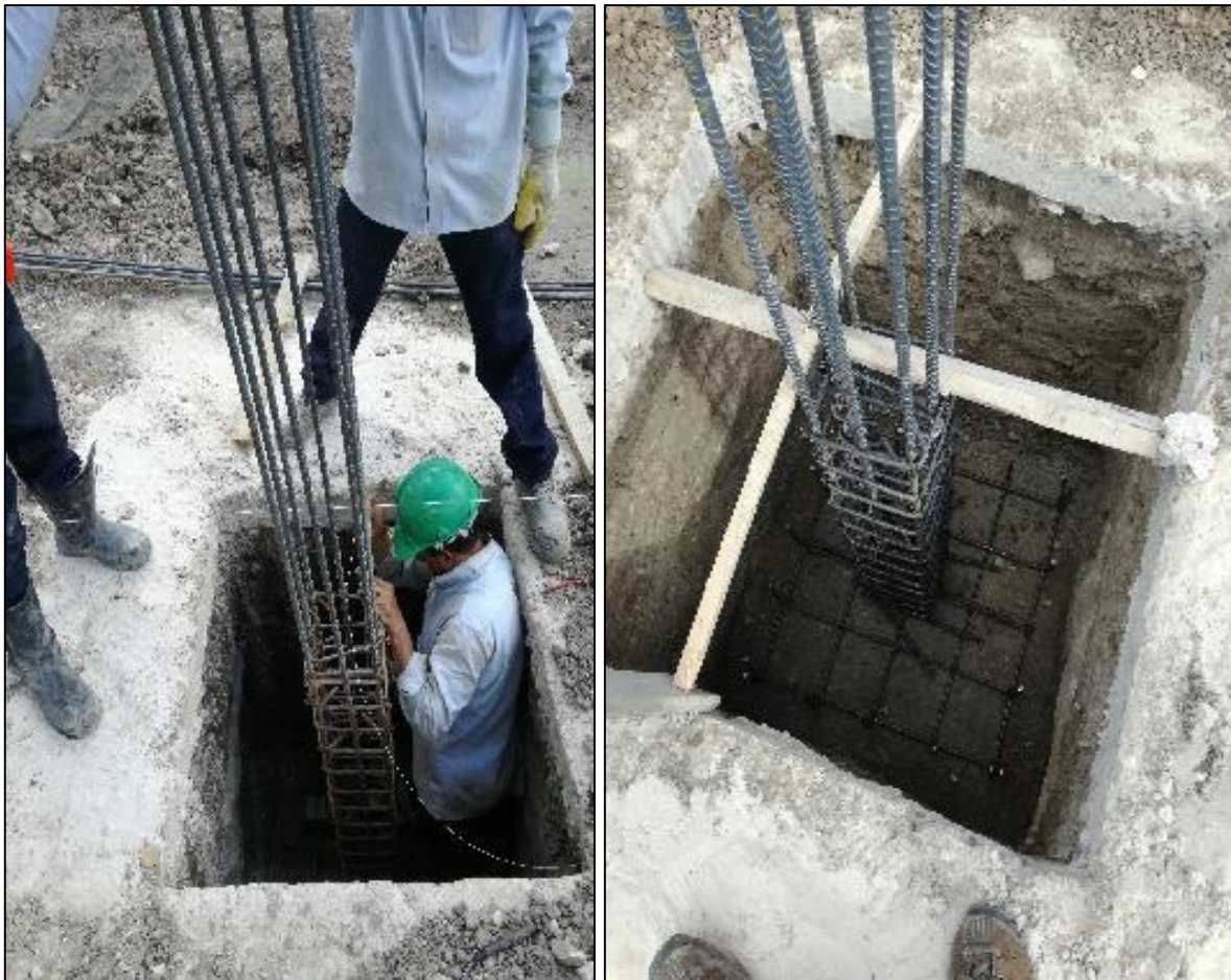
Fotografía 9: Acero de refuerzo de pedestales.
