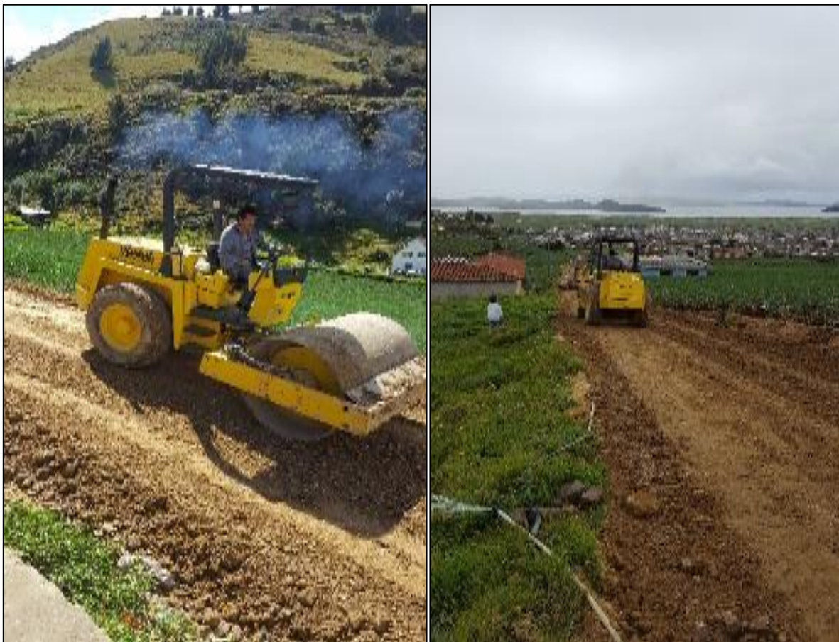
Fotografía 47: Compactación del material granular.
