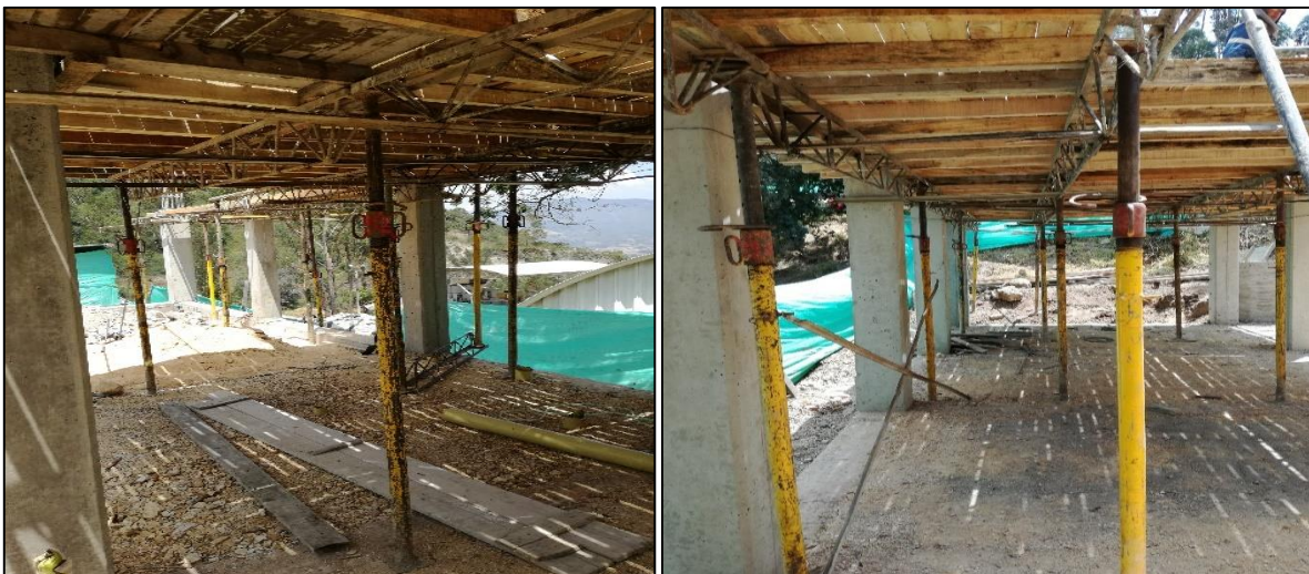
Fotografía 21: Sistema de formaleta para confinamiento de placa aligerada.
