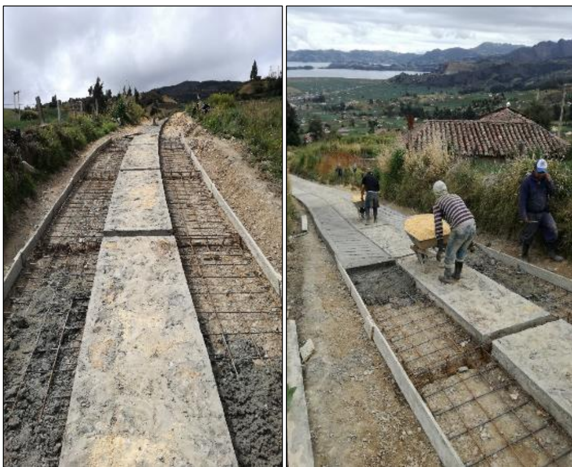
Fotografía 53: Fundida placas de acceso en concreto clase D, 3000 psi.
