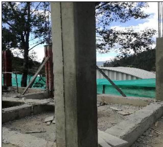
Fotografía 18: Acabado final concreto de columnas.
