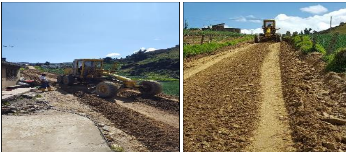
Fotografía 45: Extendido del material granular.
