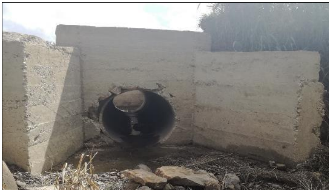
Fotografía 42: Cabezote de entrada alcantarilla ubicada en el KM 1 + 100.
