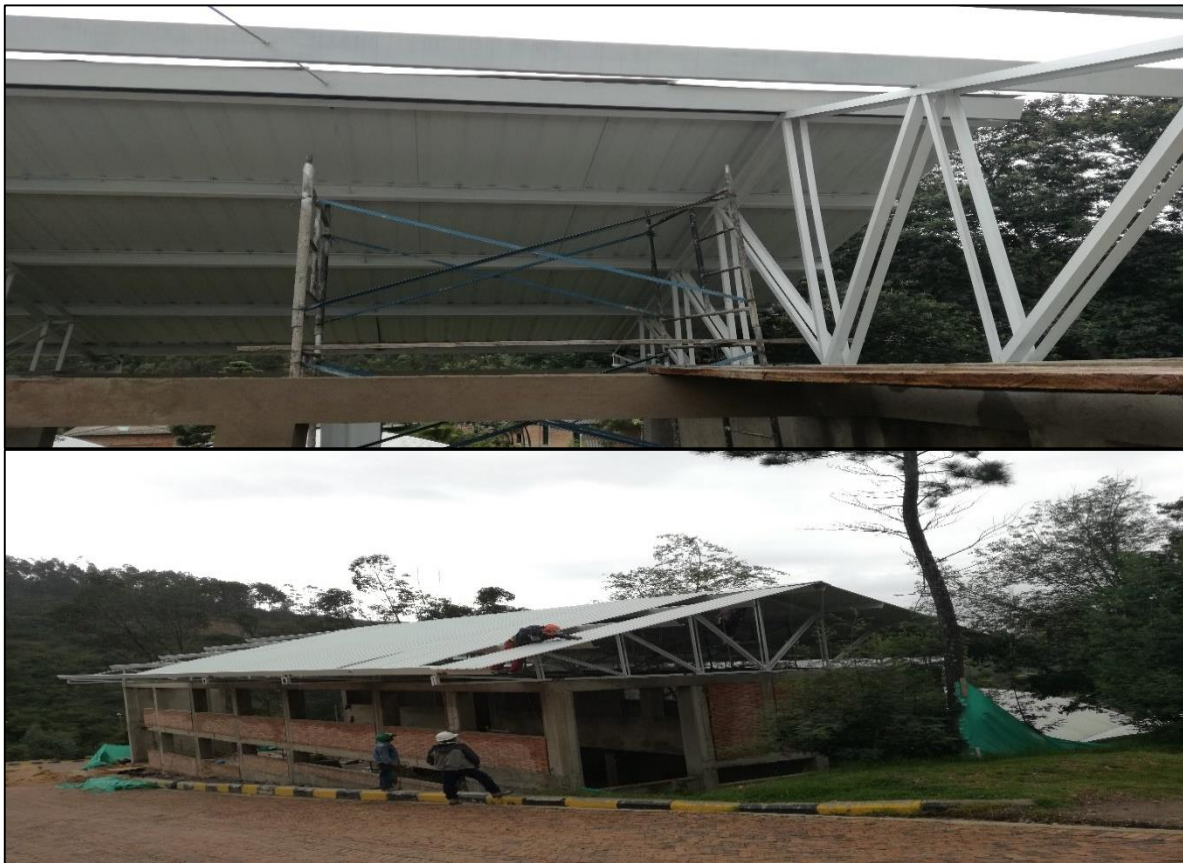
Fotografía 31: Suministro e instalación teja termo acústica.
