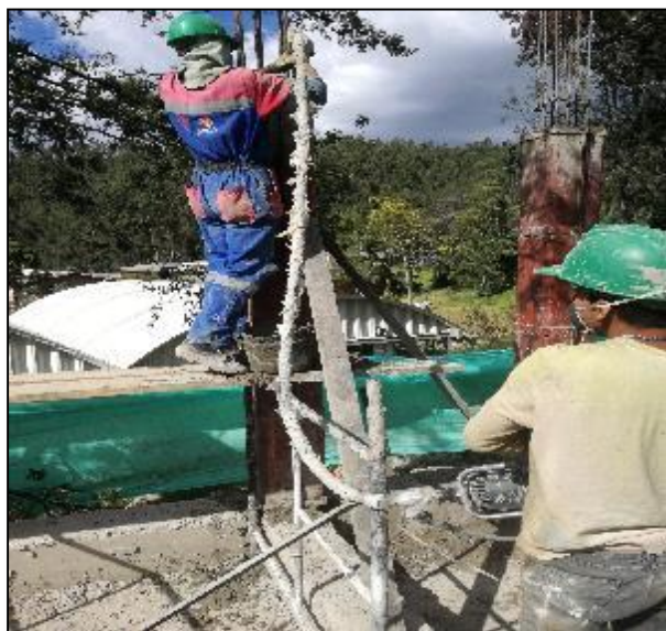
Fotografía 17: Vibrado del concreto de columnas.
