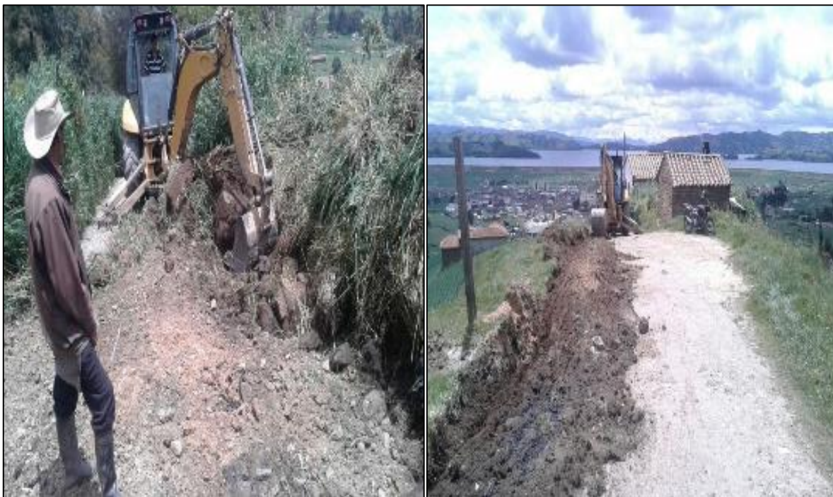
Fotografía 43: Perfilado y retiro de material vegetal.
