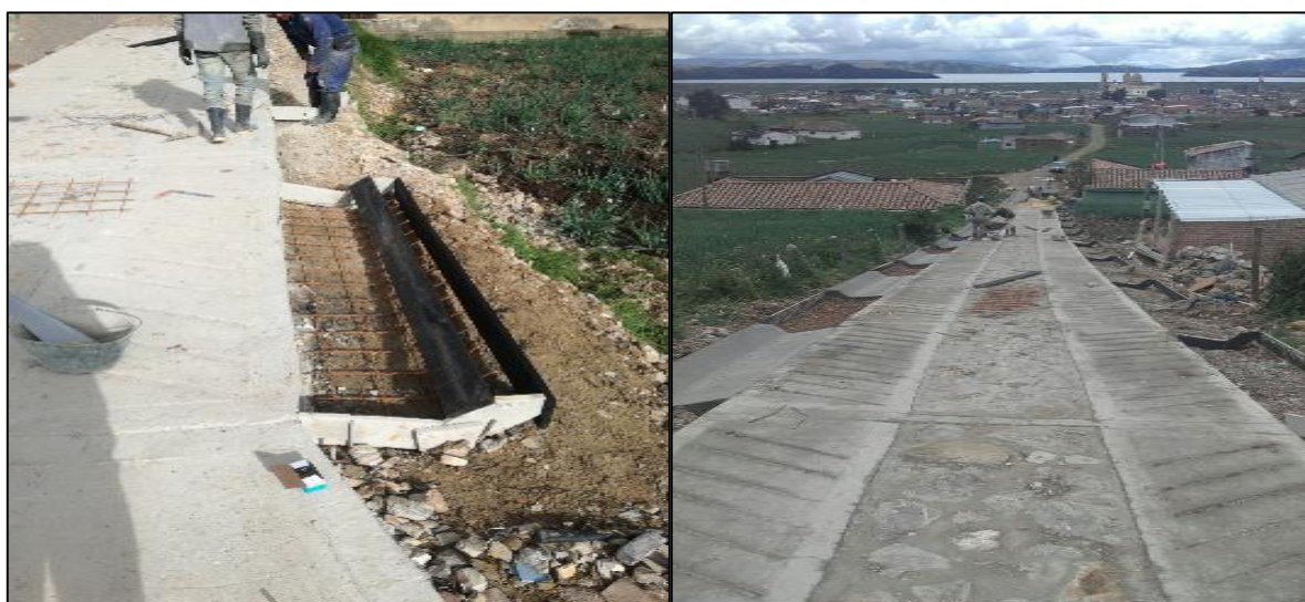
Fotografía 55: Formaleta cunetas laterales.
