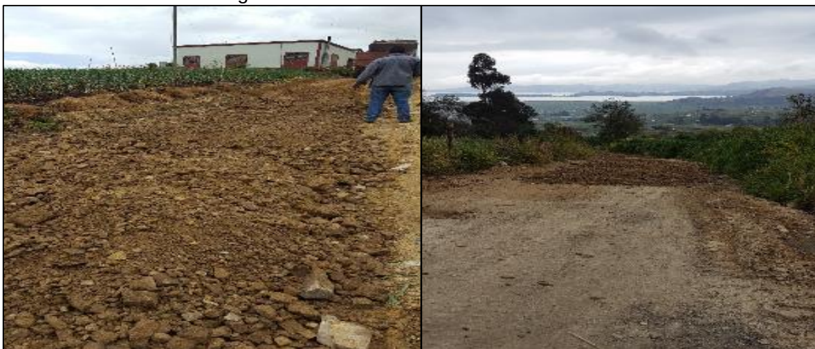
Fotografía 44: Suministro material de afirmado.
