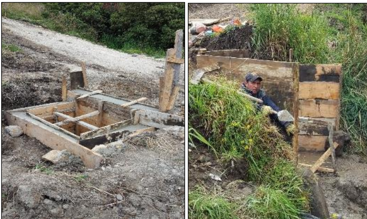
Fotografía 40: Formaleta para fundida de cabezotes de alcantarilla ubicada en el KM1+100.
