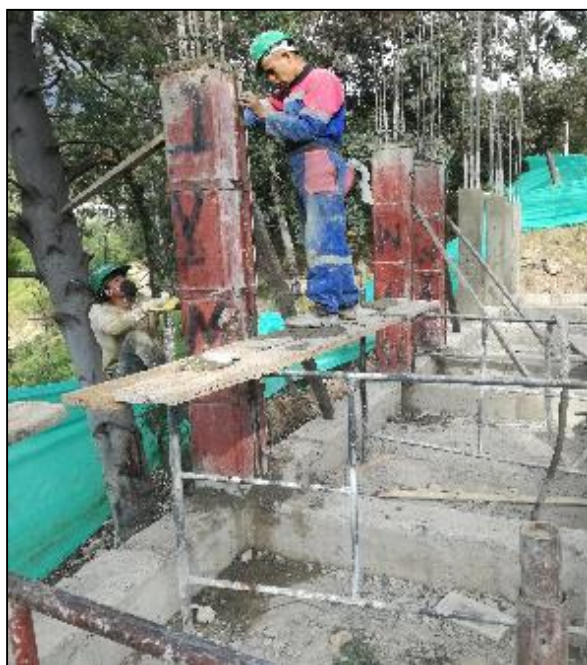
Fotografía 15: Instalación formaleta de columnas.
