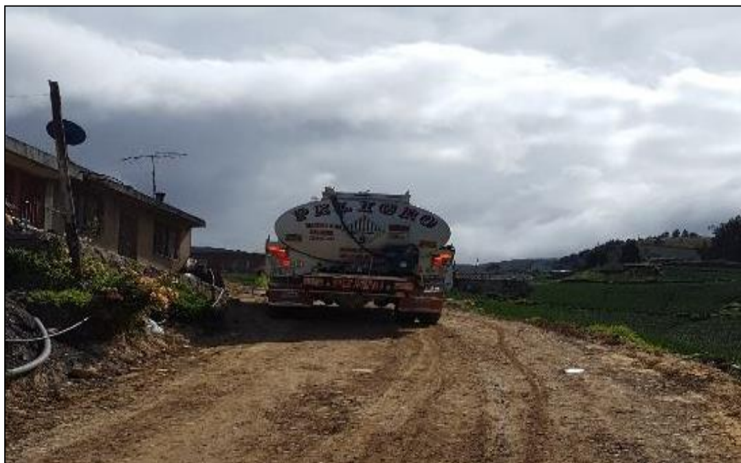
Fotografía 46: Riego sobre el material extendido median te carrotanque.
