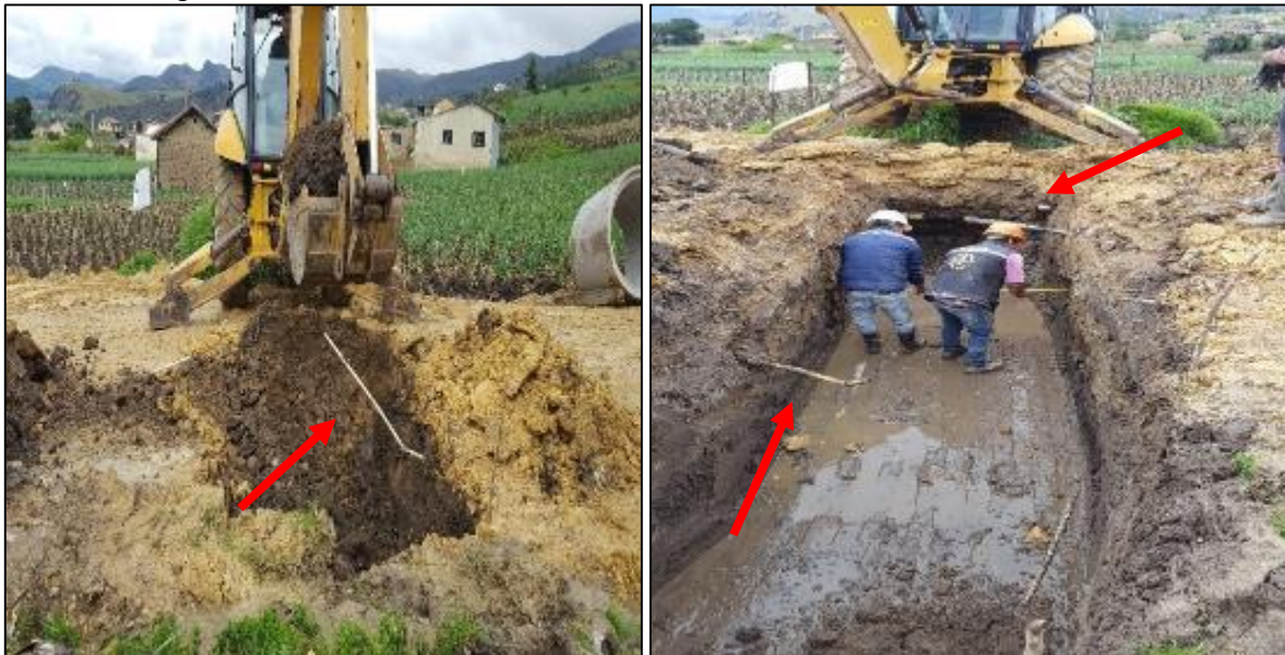
Fotografía 32: Excavación mecánica, alcantarilla ubicada en el KM 0 + 000.
