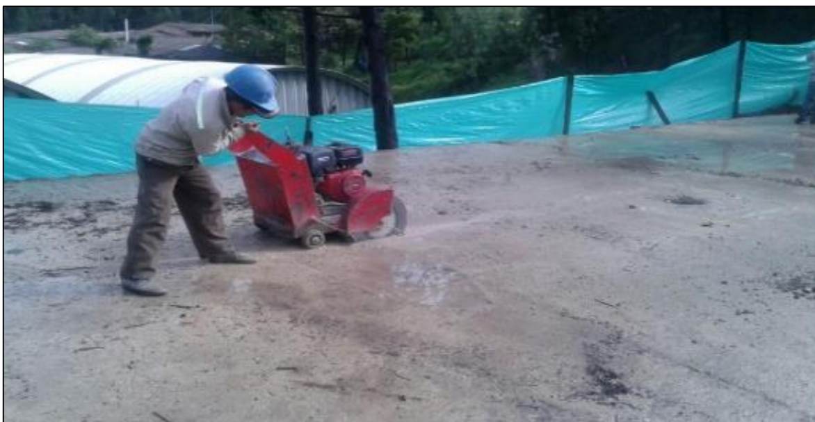
Fotografía 2: Cortes sobre la placa en concreto existente.
