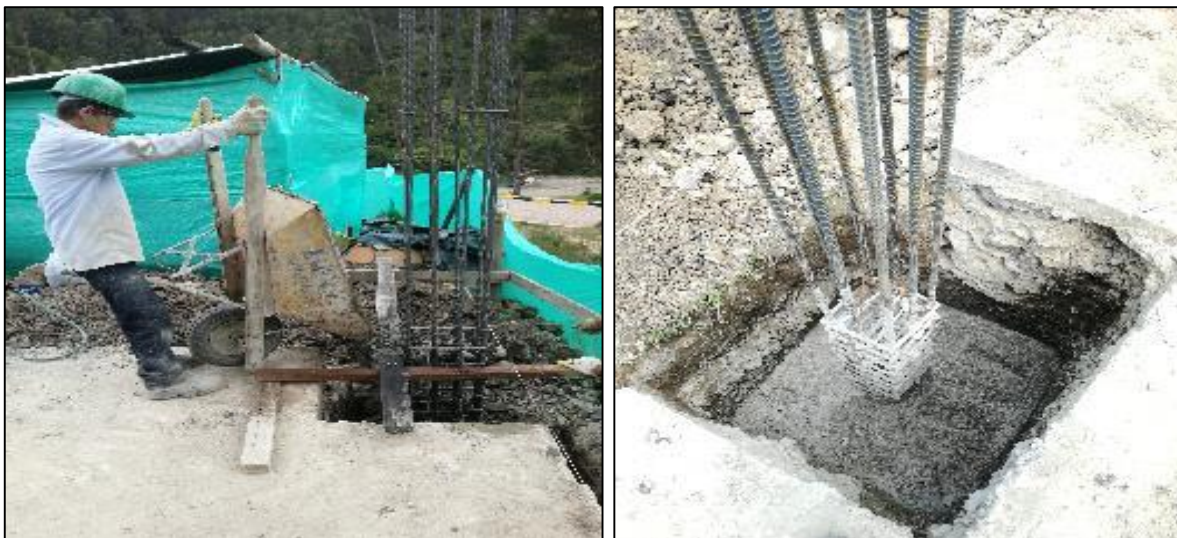
Fotografía 10: Fundida de zapatas concreto 3000 psi.
