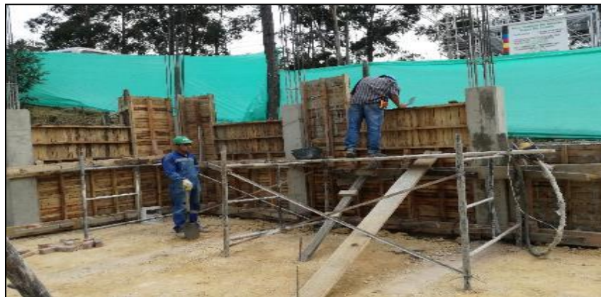
Fotografía 19: Formaleta muro de contención.
