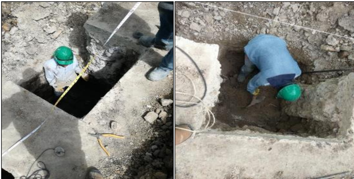
Fotografía 5: Excavación manual y retiro de material común de las zapatas.
