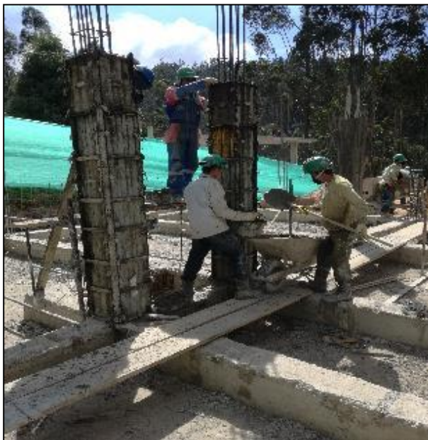
Fotografía 16: Vaciado del concreto de columnas.
