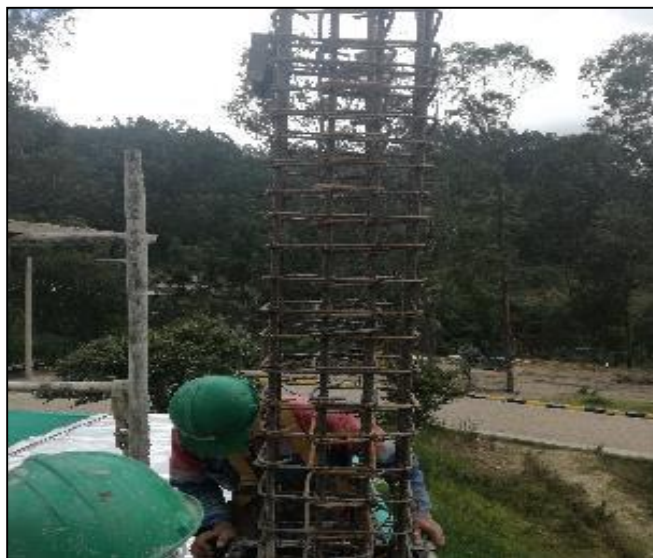
Fotografía 14: Acero de refuerzo columnas.
