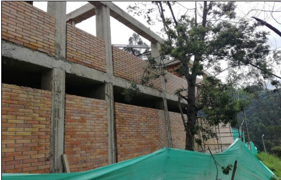
Fotografía 27: Mampostería estructural a la vista.
