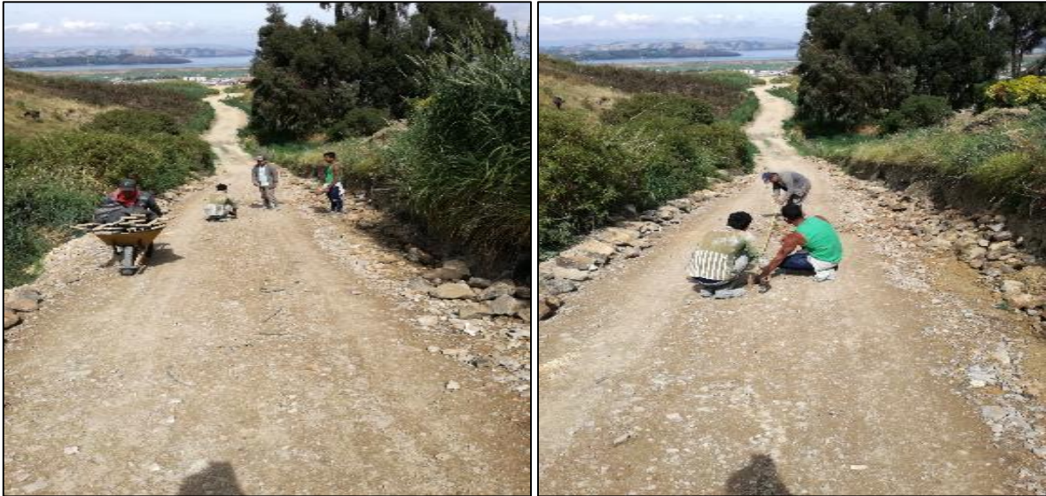
Fotografía 49: Marcación de ejes y verificación de ancho de vía.
