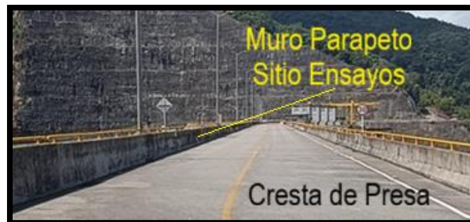
Fotografía No.3: Muro Parapeto Presa – Sitio de Ensayos – Septiembre de 2025 – Fuente Grupo de Trabajo.
