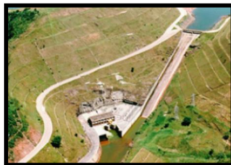
Fotografía No.7: Represa hidráulica de Jaguari (PH) – Fuente CESP (2013).
