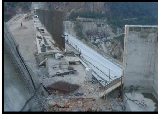
Fotografía No.2: Construcción Muro Parapeto Presa – Enero de 2014 – Fuente Empresa del Sector Eléctrico Colombiano.
