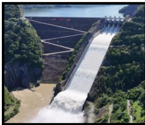
Fotografía No.1: Central Hidroeléctrica – Aguas abajo – Julio de 2025 – Fuente Grupo de Trabajo.
