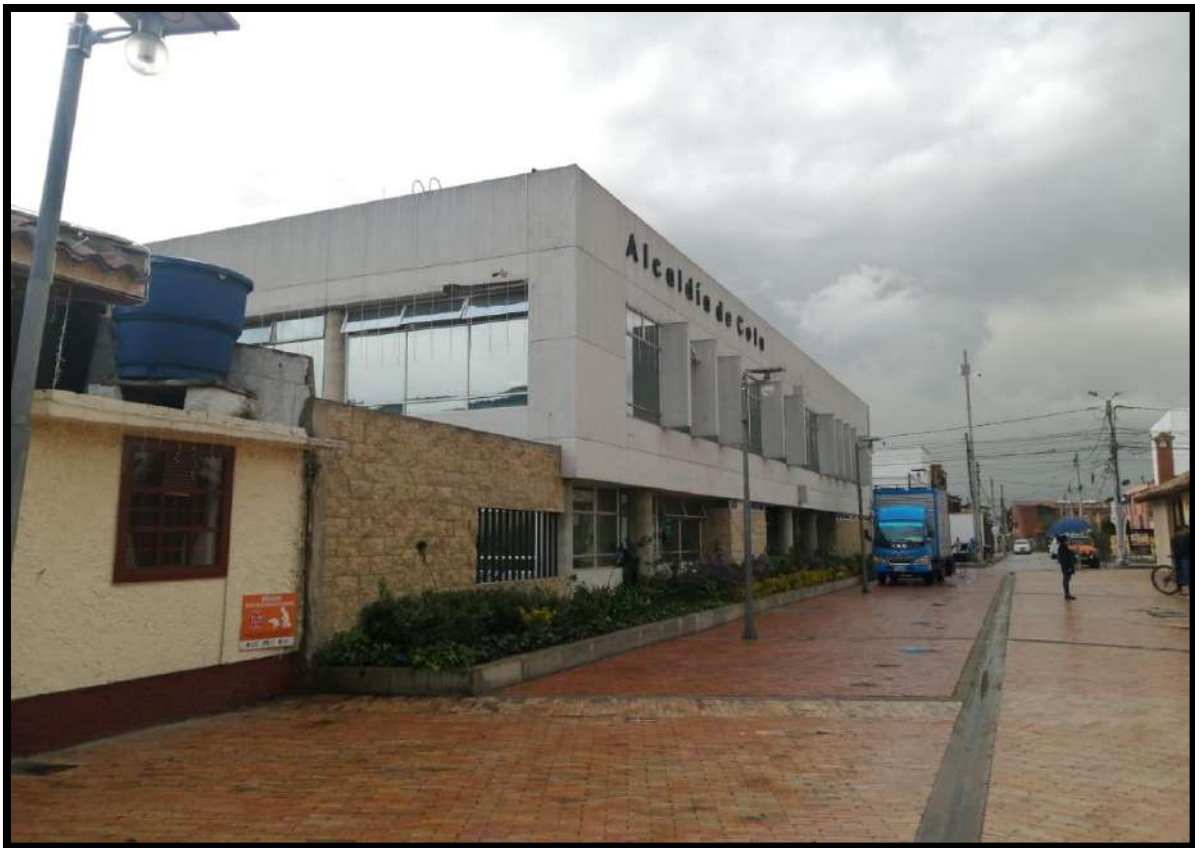
IMAGEN 11 FOTOGRAFÍA TOMADA DEL ESTADO ACTUAL DE UNA DE LAS FACHADAS.
