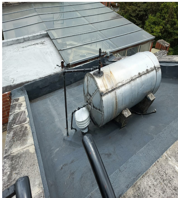
Figure 4. Techo de la vivienda familiar
