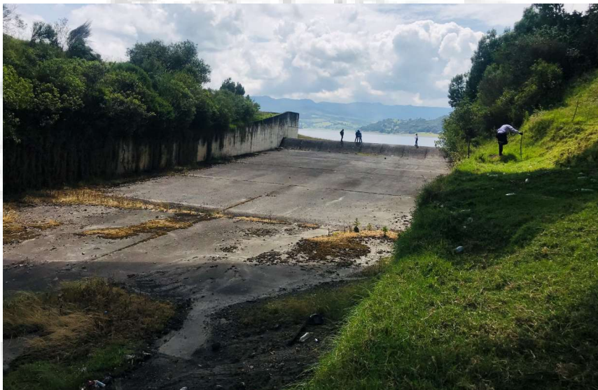
Fotografía. 1. Vertedero de excesos, aguas arriba (Azud). Fuente: Consorcio Embalses CAR, 2020.
