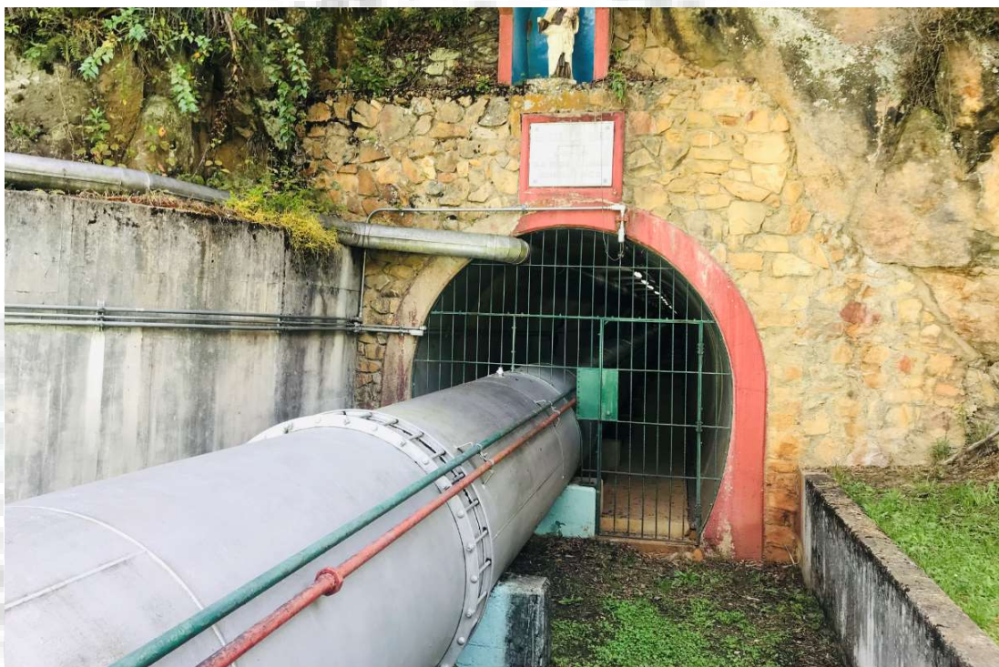
Fotografía. 3. Túnel de descarga (Portal de salida). Fuente: Consorcio Embalses CAR, 2020.
