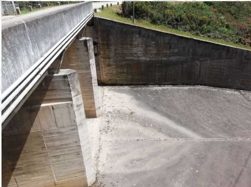
Fotografía. 10. Vista del vertedero de excesos, aguas arriba. Fuente: Consorcio Embalses CAR, 2020.
