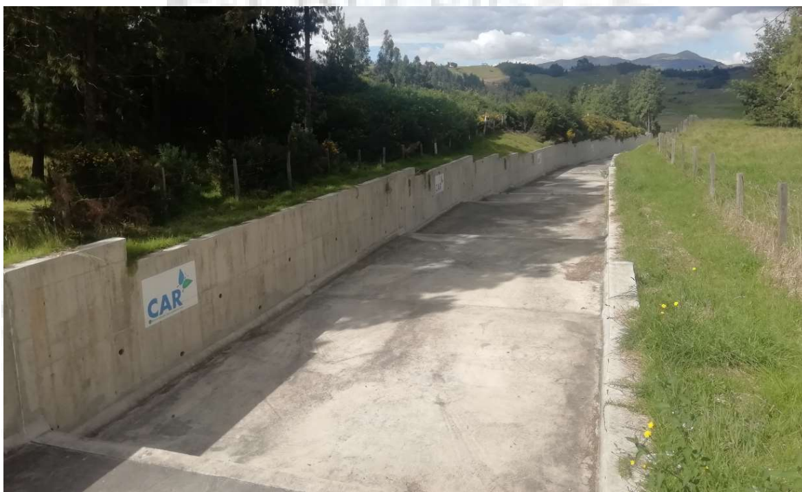
Fotografía. 11. Vertedero de excesos.
