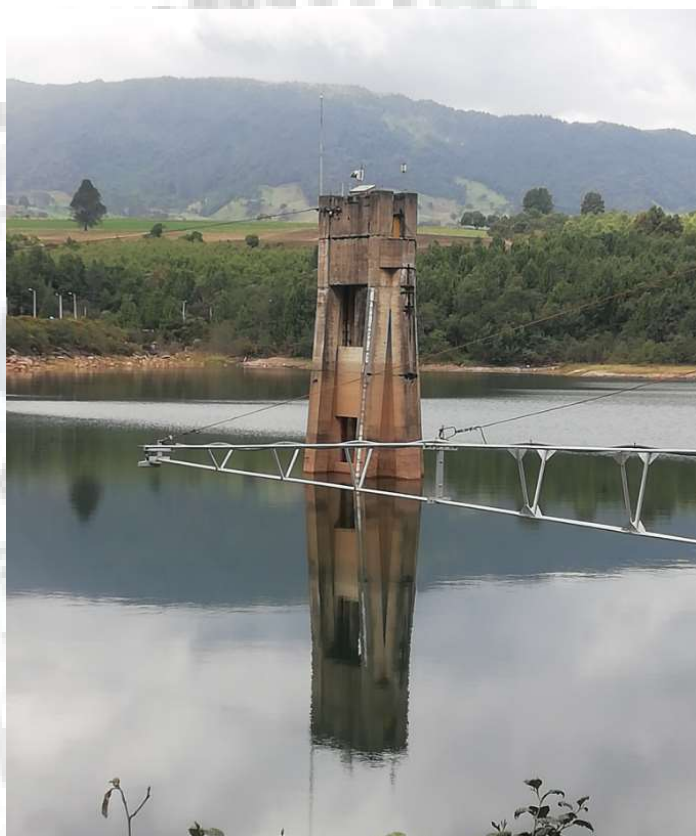
Fotografía. 5. Torre de toma.
