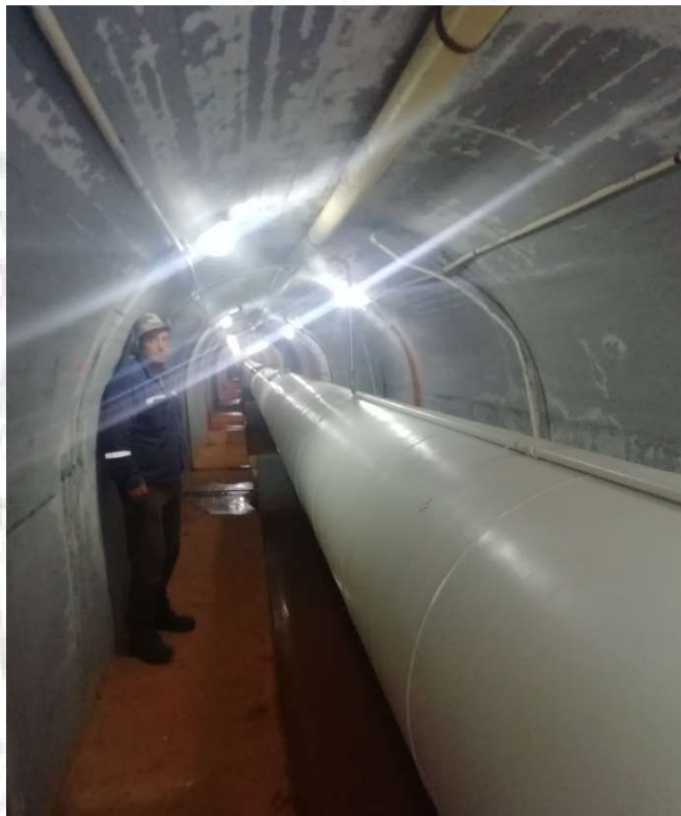
Fotografía. 14. Túnel de descarga (interior).
