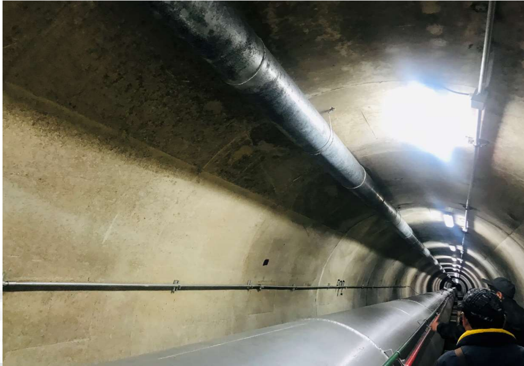
Fotografía. 4. Túnel de descarga (Interior).
