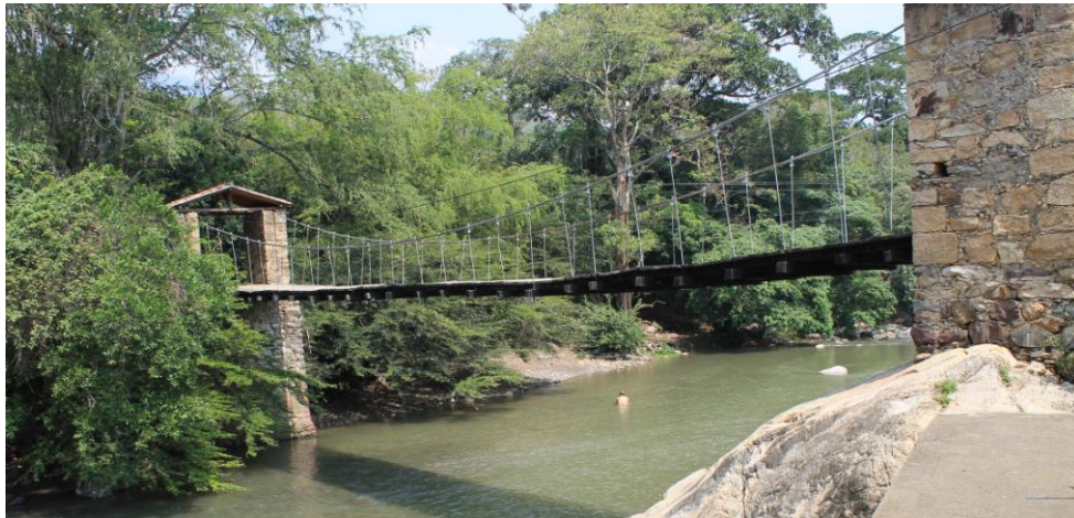
Fotografía 4 Vista del Puente de la Hamaca
