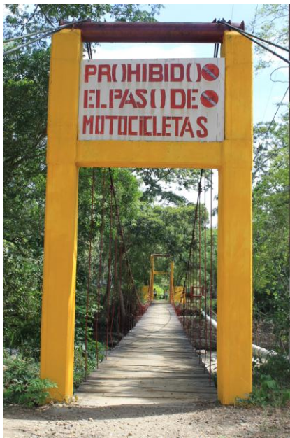
Fotografía 5 Puente La Hamaca de Villas de Santiago
