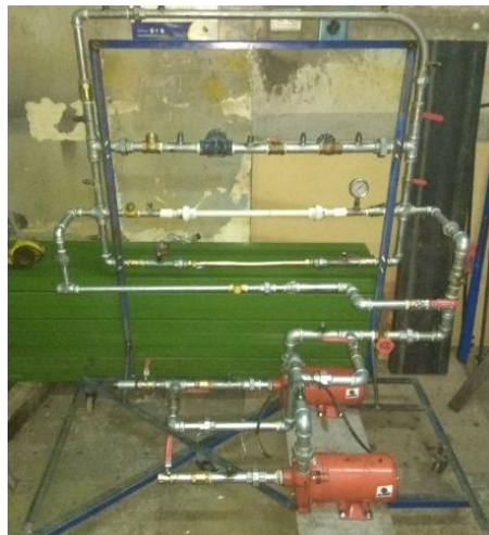
Figura 32 Banco de bombas reestructurado.
