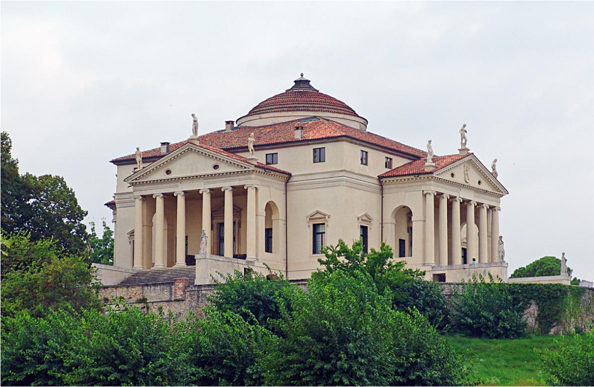
Figura 23. Villa la Rotonda. Fuente: (Wikiarquitectura, s.f.)
