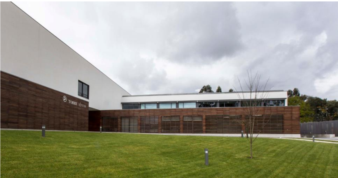
Figura 52. Acceso principal Fuente: (Quintana, 2014)
