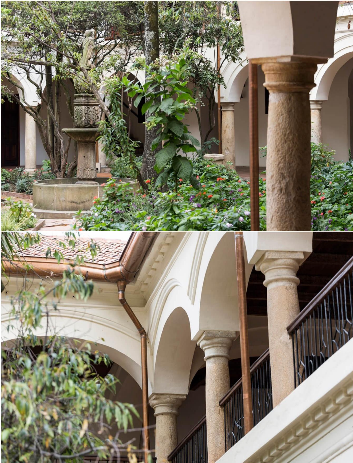
Figura 65. Detalle de columnas y arcos Fuente: (Revista AXXIS, 2018)
