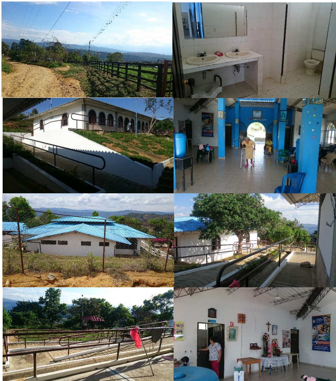
Figura 5. Fotografías estado actual Centro Geriátrico Los Santos parte 1 Fotos tomadas por el autor
