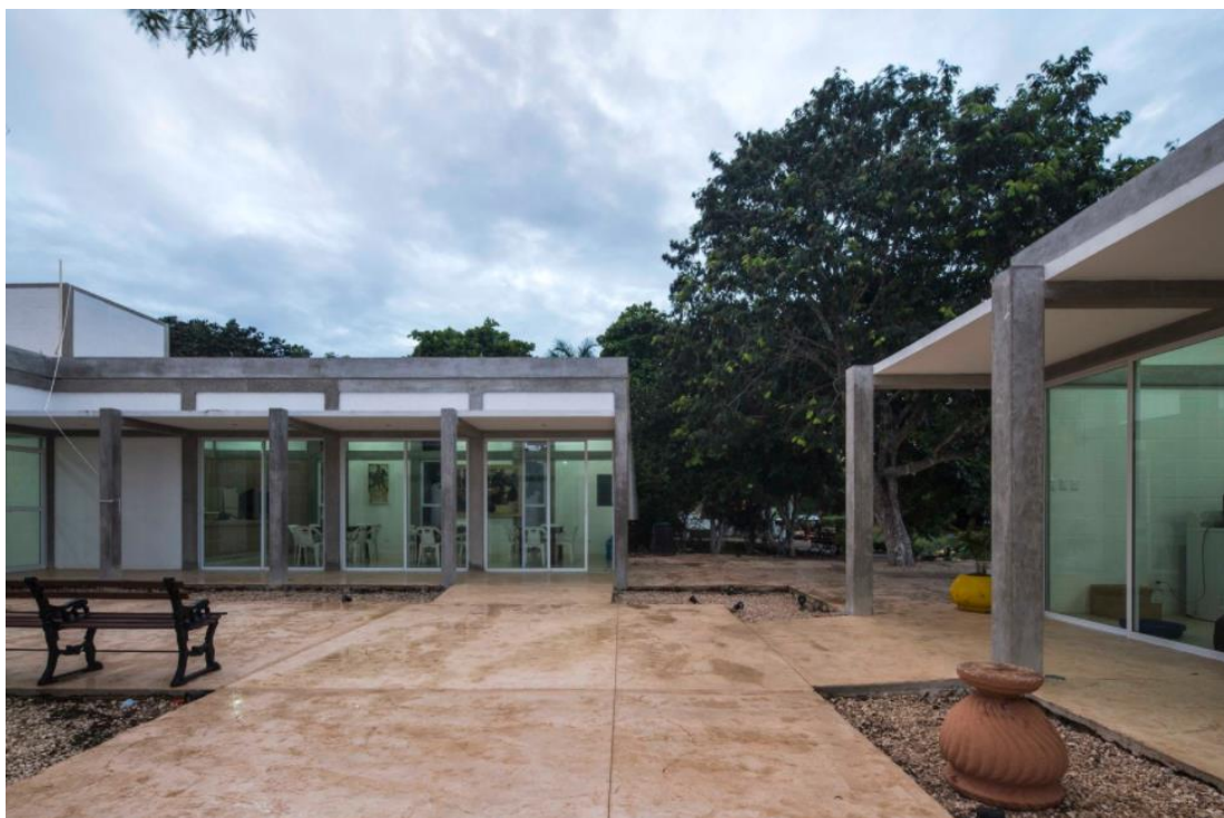
Figura 30. Detalle exterior Fuente: (Morfín, 2016)
