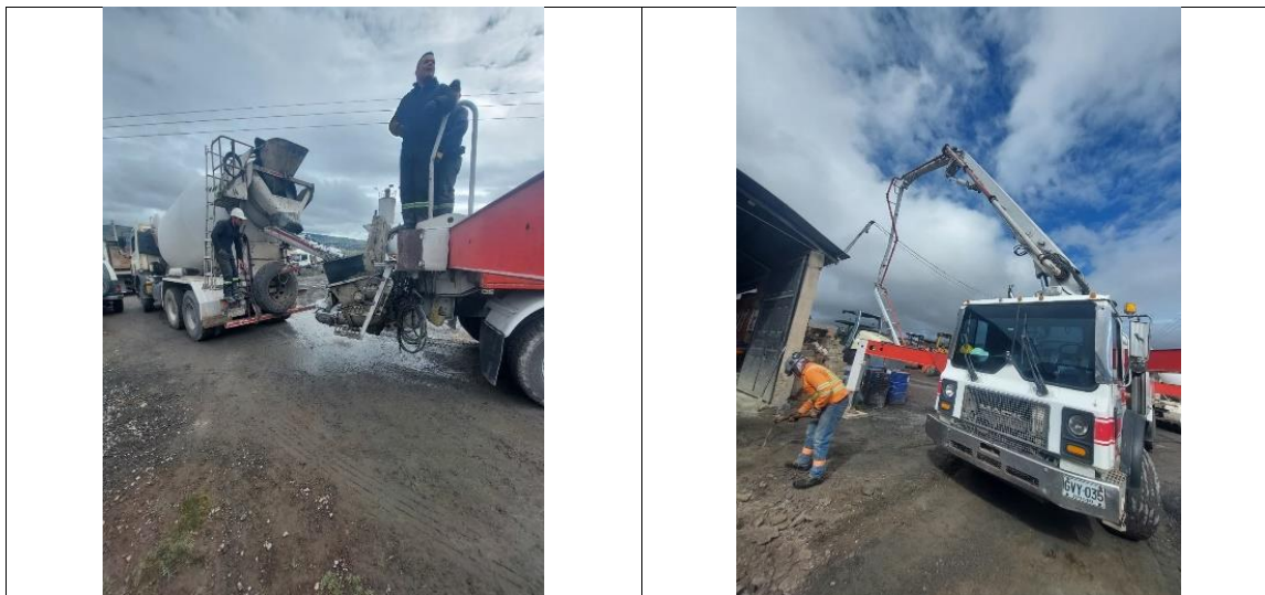
Figura 32. Suministro con bomba de concretos
