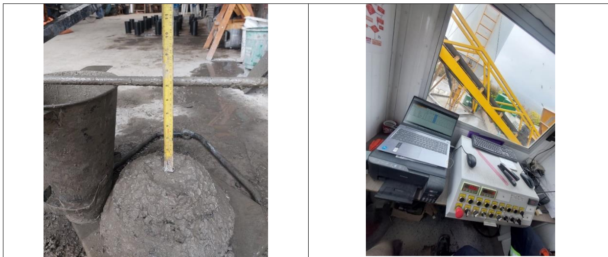
Figura 27. Ensayo de asentamiento y trabajo en planta de concreto
