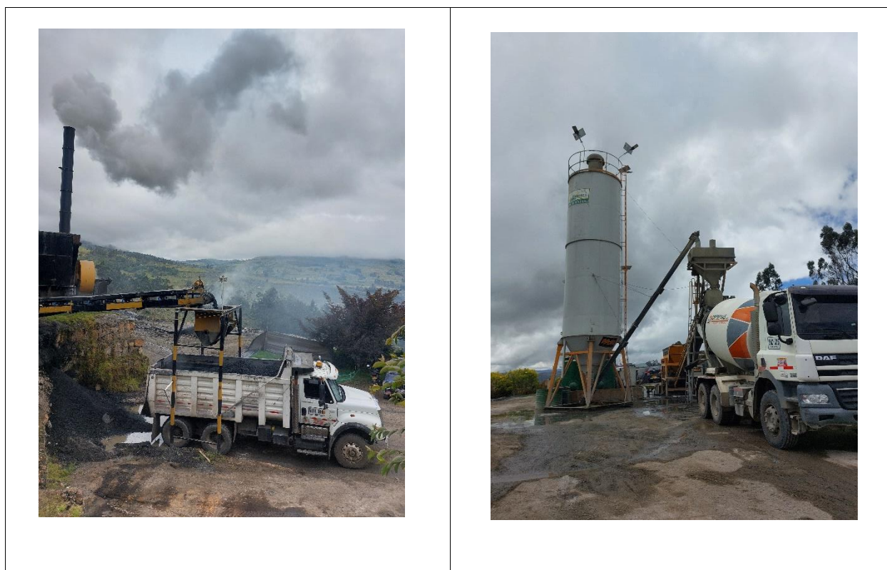
Figura 3. Planta de asfalto y concreto
