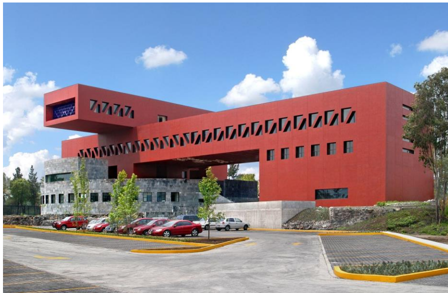
Ilustración 23 Edificio de Posgrados UNAM México
