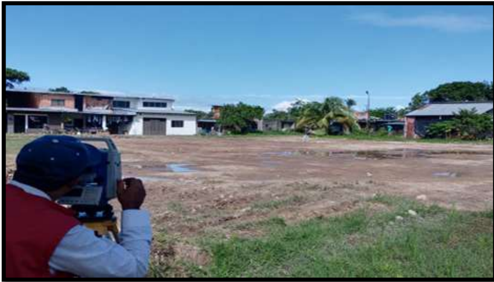
Figura 1. Localización y replanteo topográfico del terreno de la obra.
