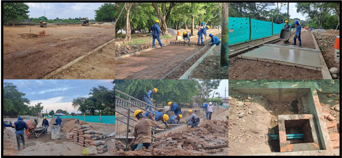
Figura 26. Registro fotográfico construcción y mejoramiento del espacio público
