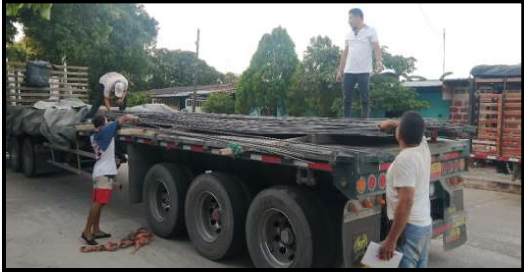
Figura 2. Recepción de varilla en bodega.
