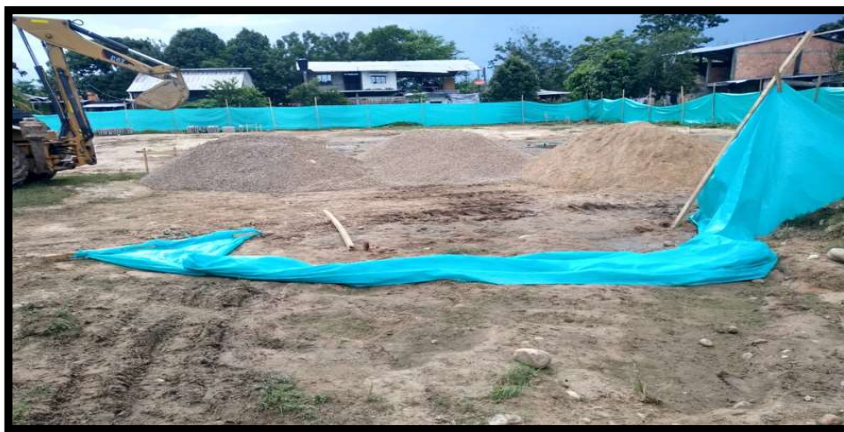
Figura 4. Acopio de materiales granulares.
