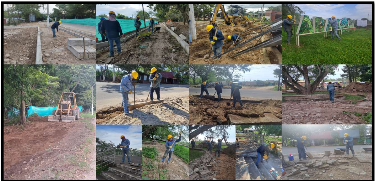
Figura 24. fotográfico construcción y mejoramiento del espacio público.
