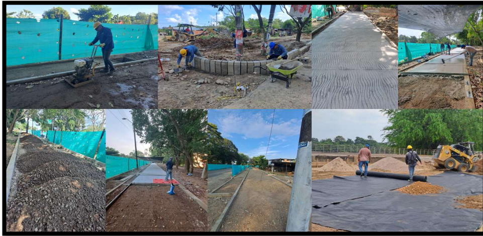
Figura 25. Registro fotográfico construcción y mejoramiento del espacio público
