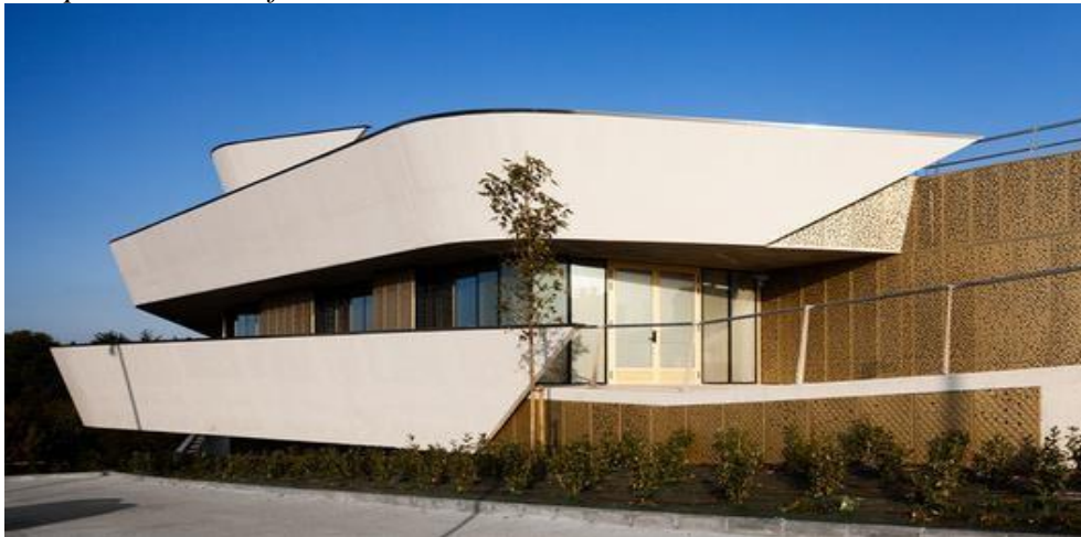
Figura 4. Perspectiva del edificio
