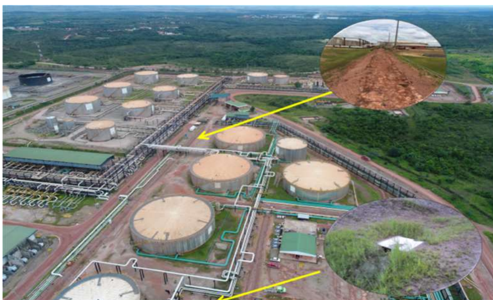
Figura 5. Identificación de lesiones durante la inspección preliminar.
