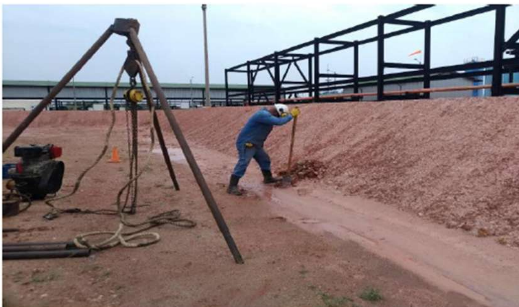
Figura 15. Aspecto de las condiciones del dique.
