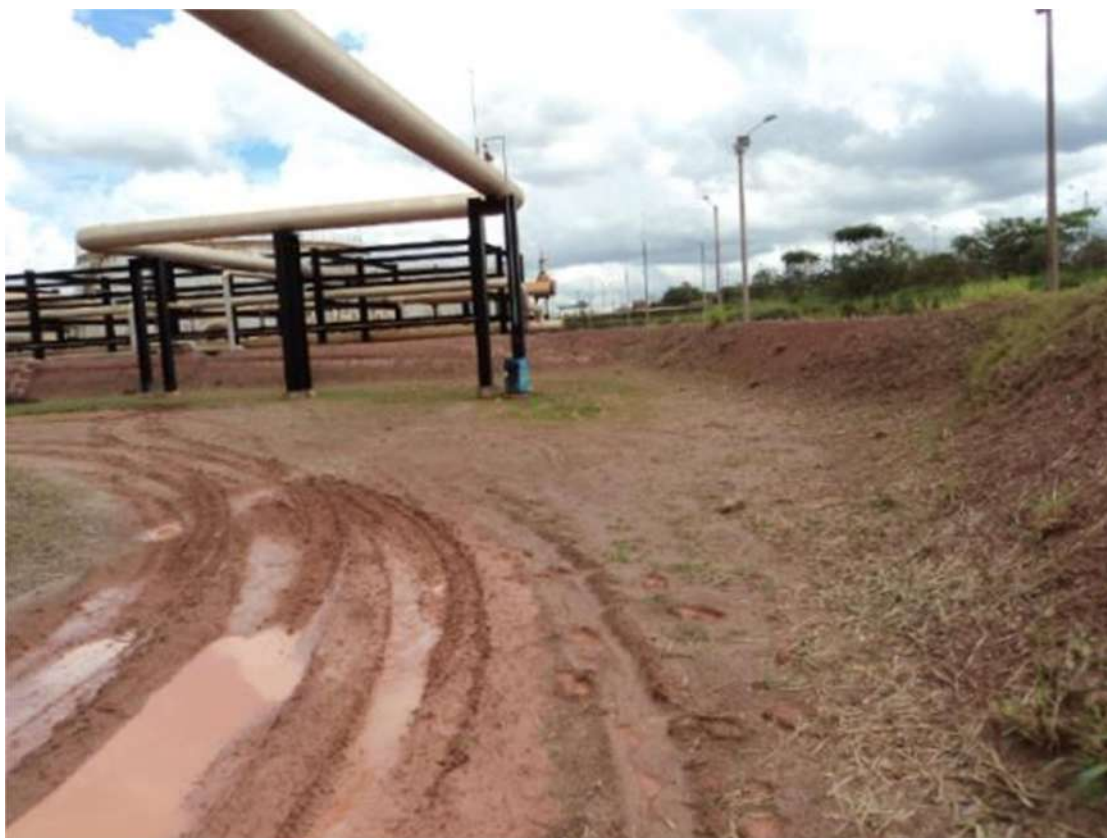
Figura 9 . Vista del estado actual que se encuentra los muros de contención, Mayo 2019.
