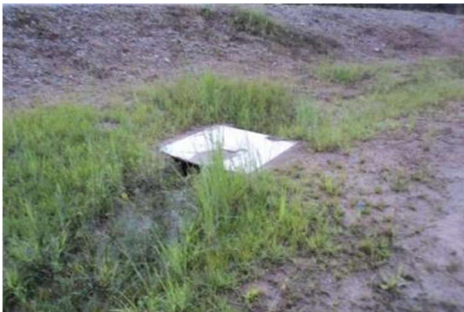
Figura 19. Estado actual del sistema de drenaje.
