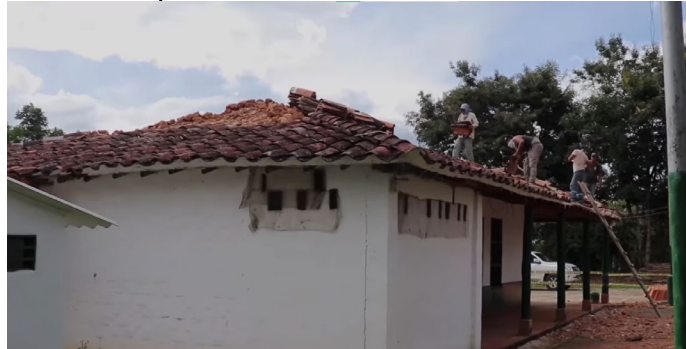
Figura 14. Actual remodelación que se le hacen a las cubiertas de la escuela
