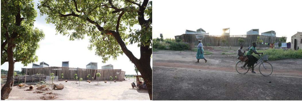
Figura 37. Cerramiento, Escuela Secundaria Lycee Schorge
