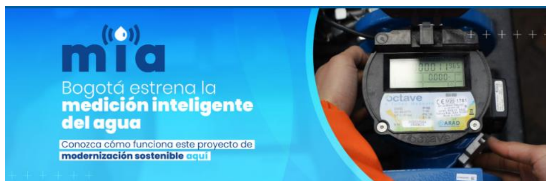
Figura 7. Medidor inteligente de agua, proceso instalación MIA
