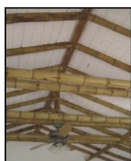
1 Estructura de cubierta.
