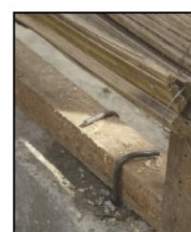
5 Pared con cimientos.
