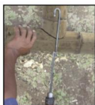
Figura 49. Uniones / Perno tensor.
