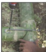
Figura 49. Uniones / Perno tensor.
