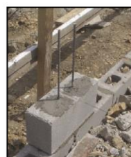
1 Fijar varilla a cimentación.
