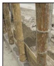
2 Colocar columnas.
