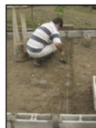
5 Cimentación paredes int.
