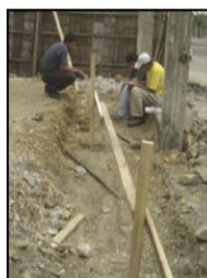
1 Trazado y nivelación.
