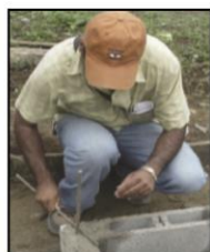
1 Fijar varilla a cimentación.
