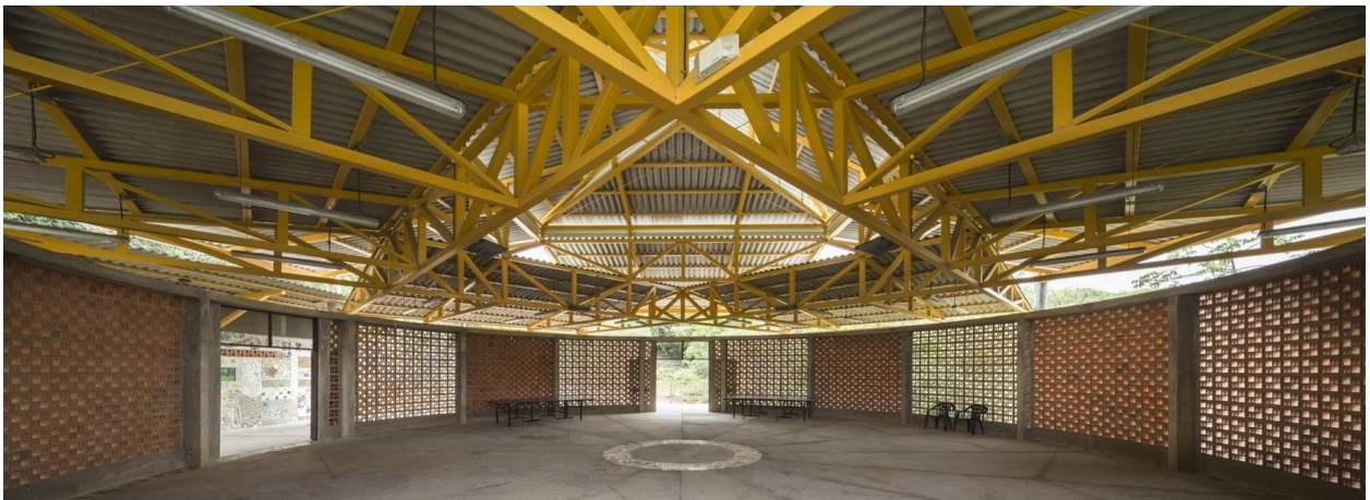
Figura 12. Ventilación. Centro comunitario del rodeo de mora. Adaptado de Archdaily, 2016.
