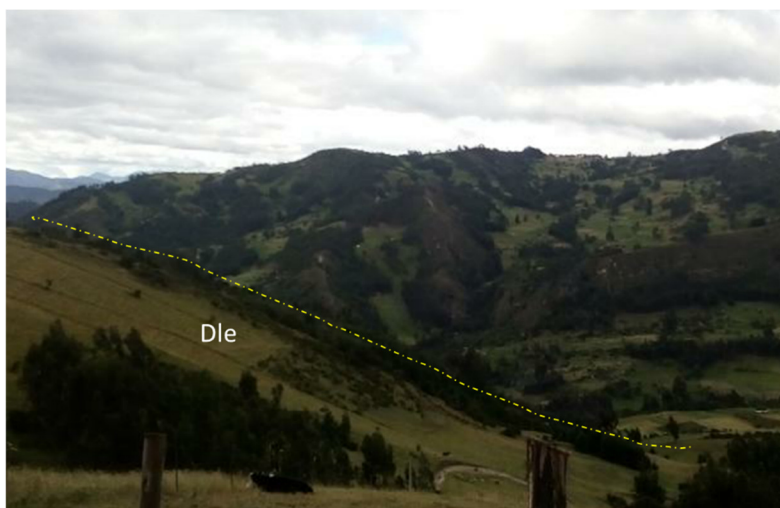
FIGURA 34. Ladera Erosiva (Dle)
