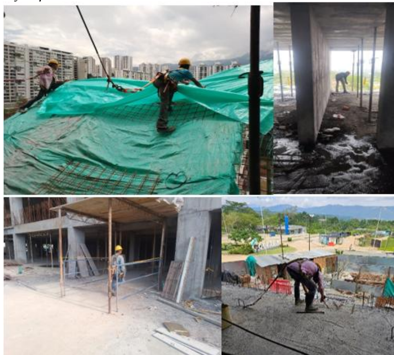
Figura 11. Seguridad y supervisión en zonas elevadas.
