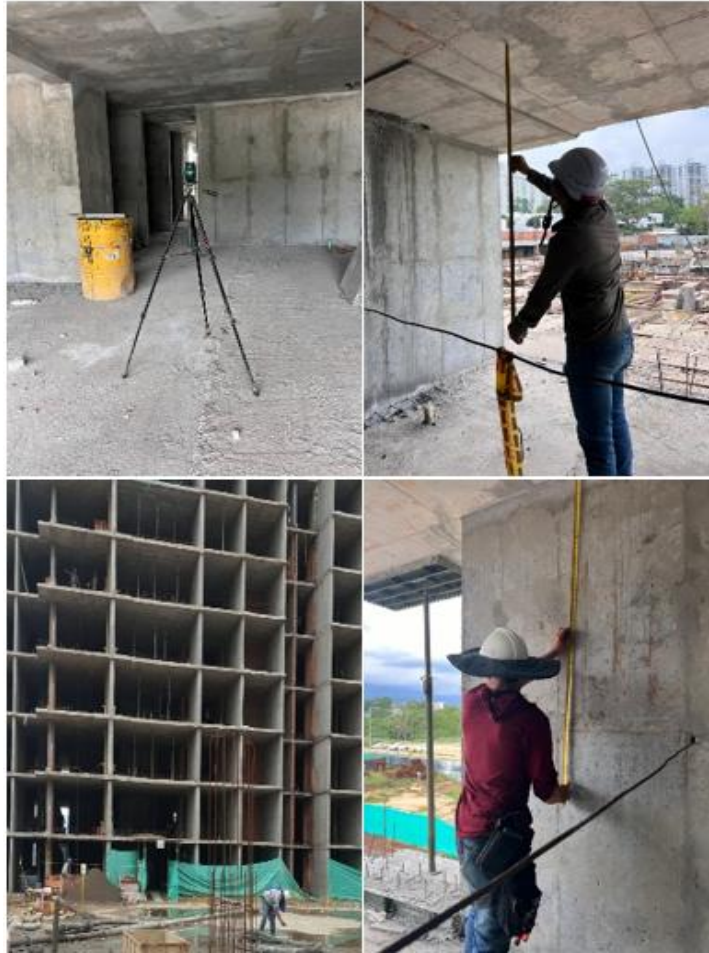
Figura 8. Supervisión niveles de placa en luces grandes.
