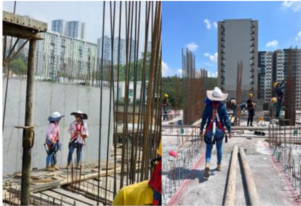
Figura 10. Recorridos de obra con la SISO de MADE.
