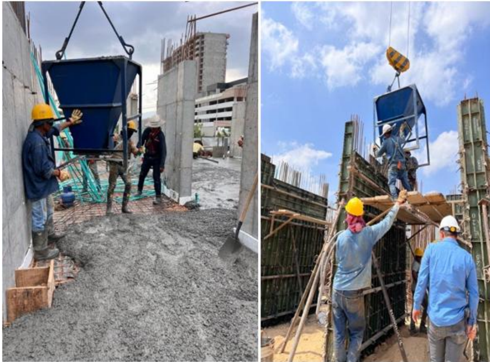
Figura 2. Supervisión fundida de obra.
