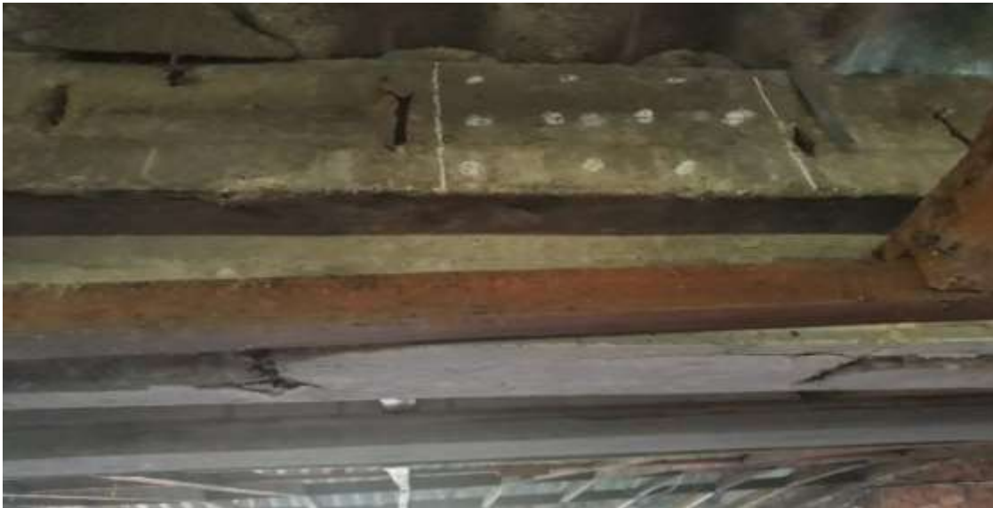
Figura 16 Observación de Huella de Impactos Realizados- Fuente: Autores
