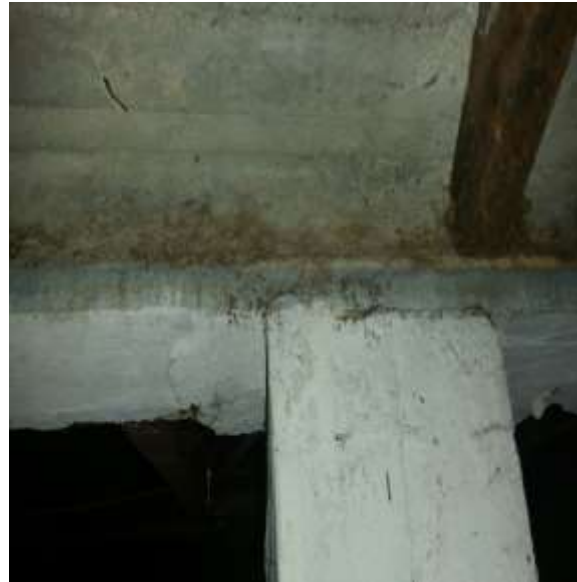
Viga canal parte interior- Corrosión del acero y desprendimiento causado por humedad.
