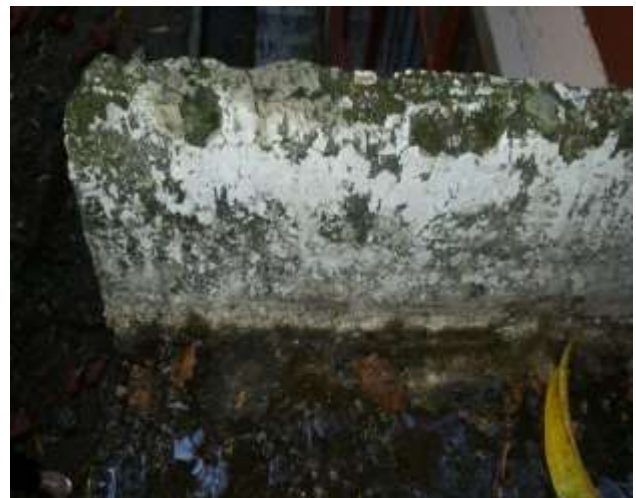
Figura 18 Erosión-Parte Externa Viga Canal Fuente: Propia
