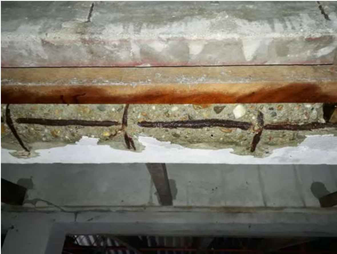
Figura 10 Aplicación de la fenolftaleína en el elemento de concreto- Fuente: Autores
