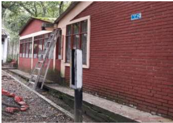
Figura 19 Suciedad por depósito superficial - Fuente: Propia
