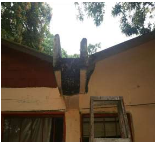
Figura 18 Erosión-Parte Externa Viga Canal Fuente: Propia
