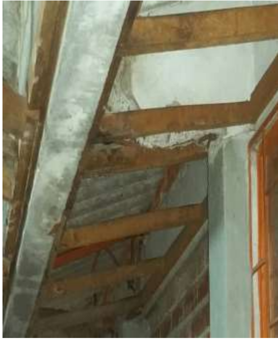
Viga canal parte interior- Corrosión del acero y desprendimiento causado por humedad.
