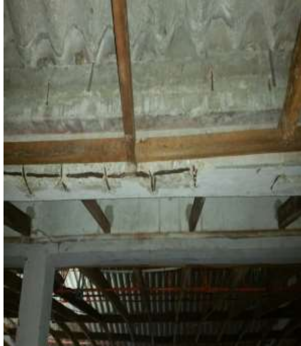
Viga canal parte interior- Corrosión del acero y desprendimiento causado por humedad.
