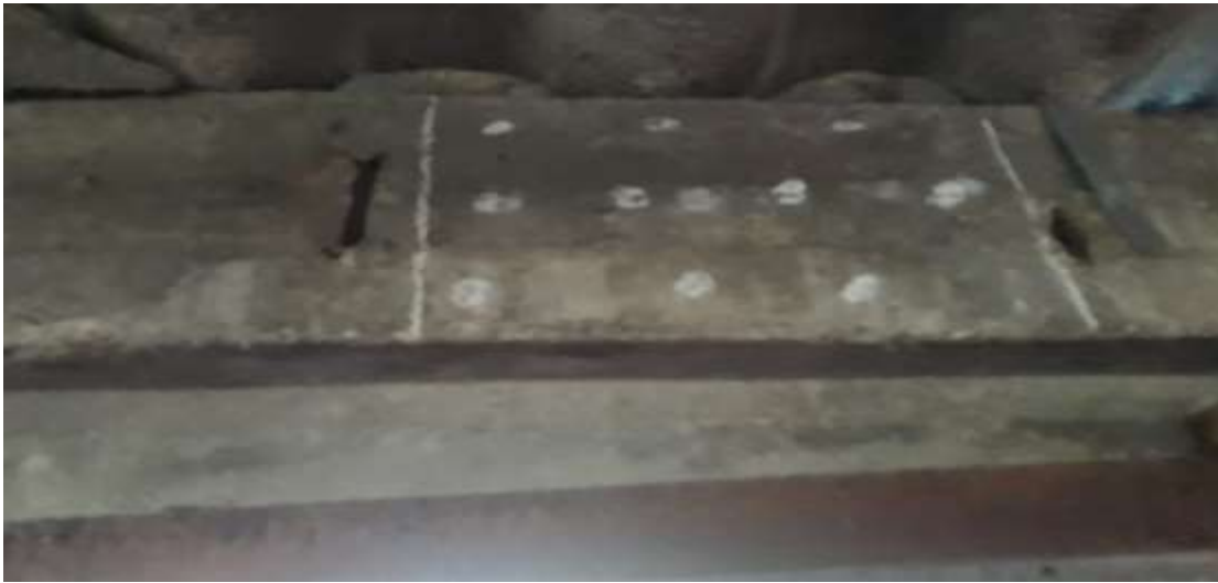
Figura 15 Zona utilizada para Ensayo Esclerometría- Fuente: Autores
