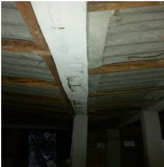
Viga canal parte interior- Corrosión del acero y desprendimiento causado por humedad.
