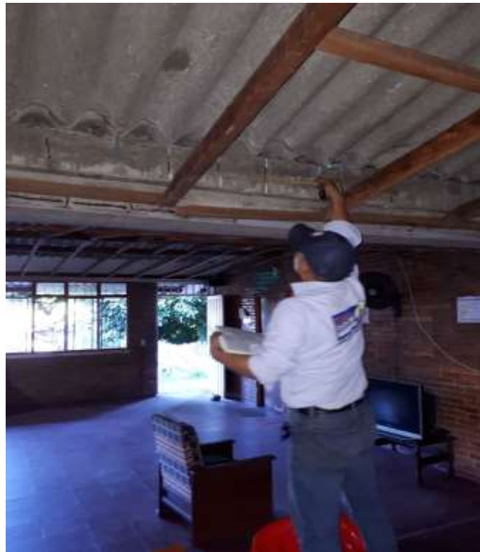
Figura 13 Medición Del Espaciamiento entre estribos- Fuente: Autores
