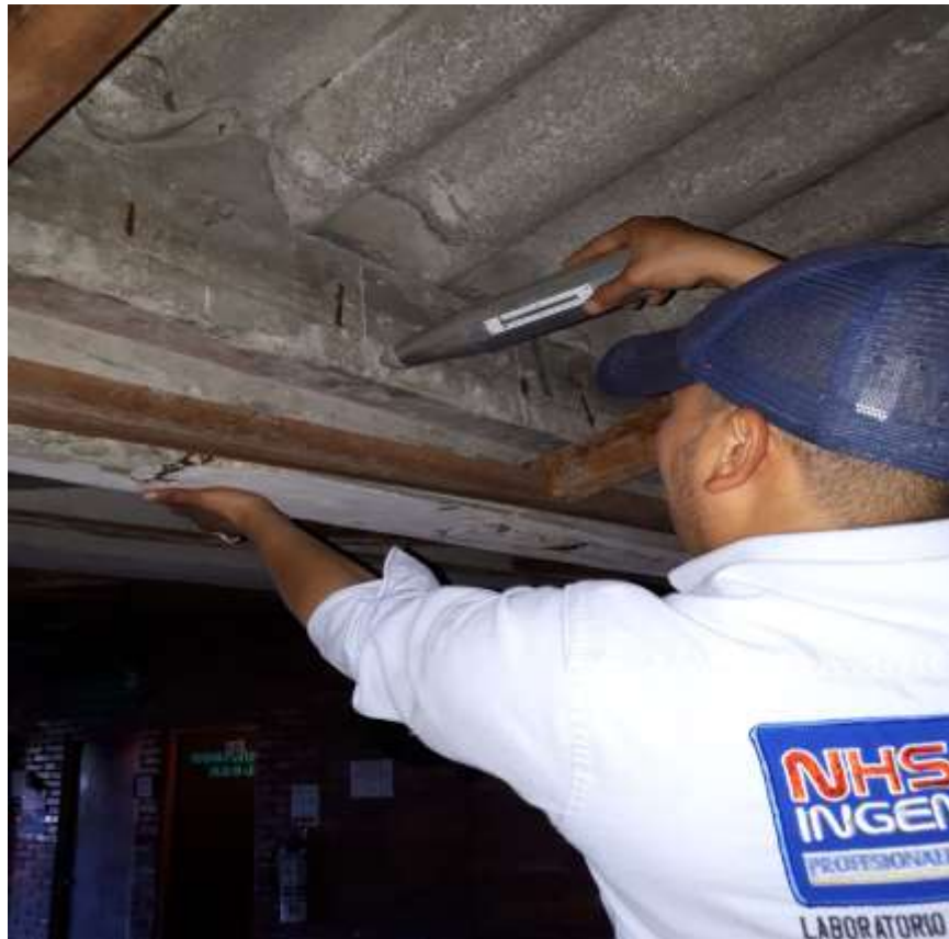
Figura 14 Ensayo para medir el número de rebote del concreto endurecido- Fuente: Autores
