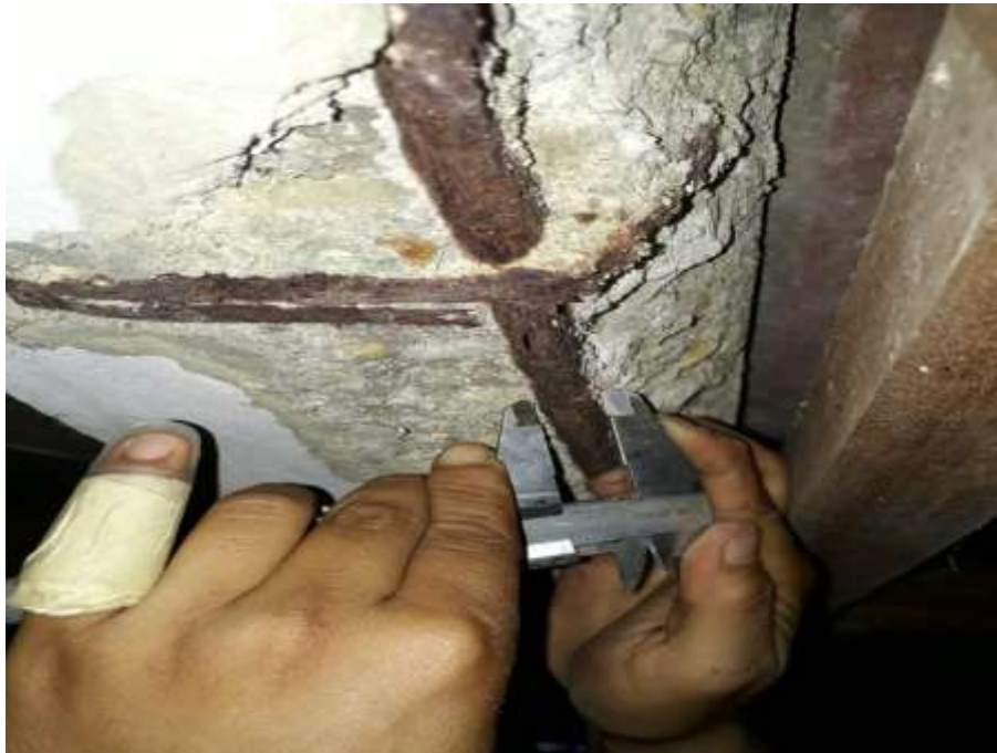
Figura 11 Medición del diámetro de acero de refuerzo- Fuente: Autores
