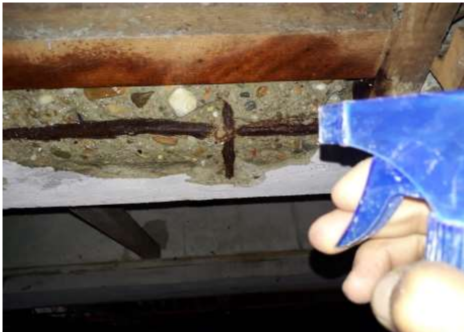
Figura 9 Aplicación de la fenolftaleína al elemento expuesto.- Fuente: Autores
