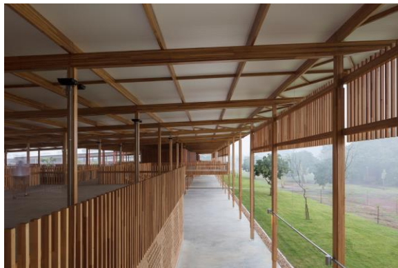
Figura 13. Malla de pilares y muros en ladrillo.
