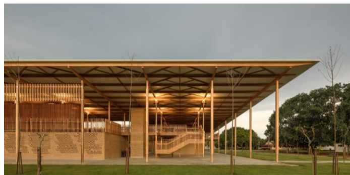
Figura 11. Elevación de la cubierta por medio de pilares.
