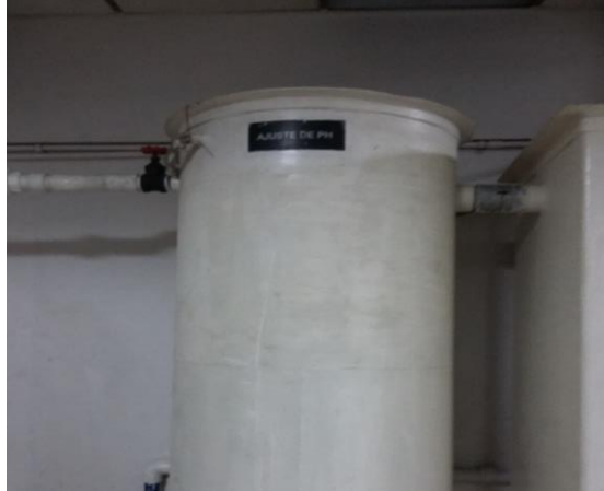
Fotografía 1-1 Tanque de ajuste de pH
