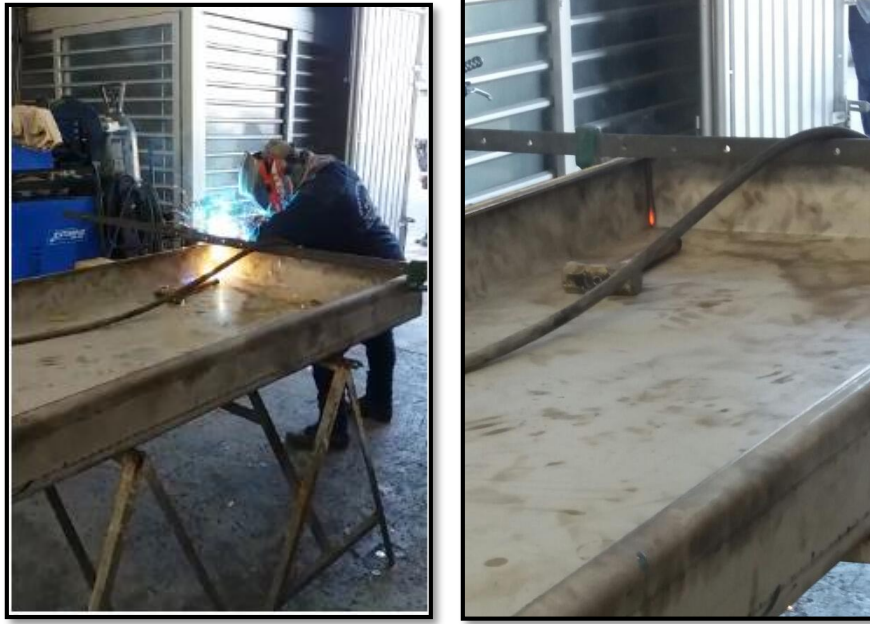
Figura 3-36 Soldadura del tanque de arena. Fuente: Autores
