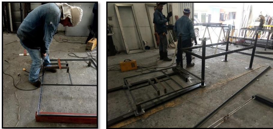
Figura 3-47 Construcción de estructura de soporte de tanque de agua. Fuente: Autores
