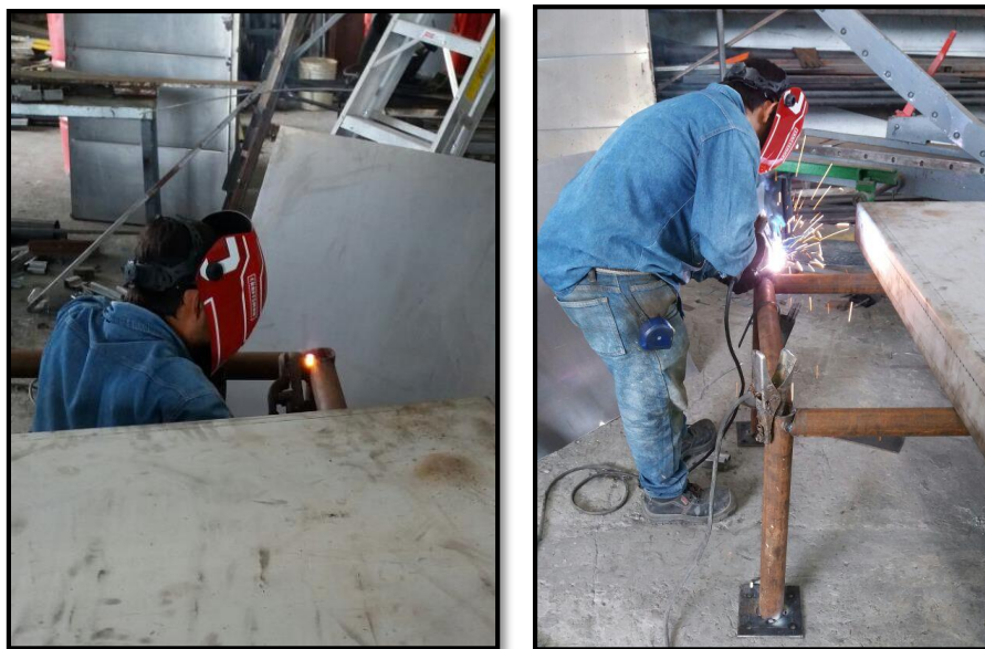
Figura 3-39 Soldadura de estructura de soporte. Fuente: Autores
