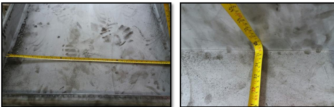
Figura 3-33 Verificación de medida del ancho del tanque de arena. Fuente: Autores.
