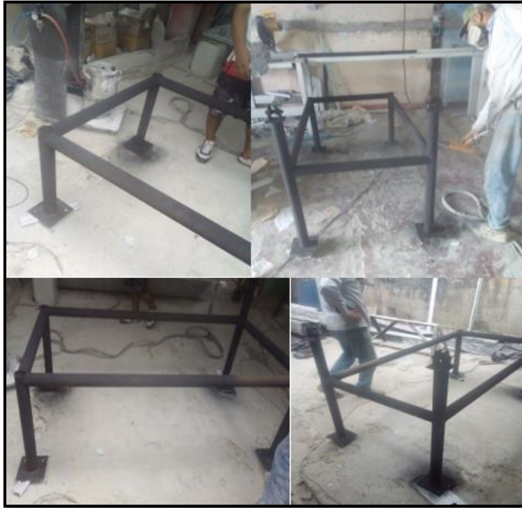
Figura 3-42 Proceso de pintura. Fuente: Autores
