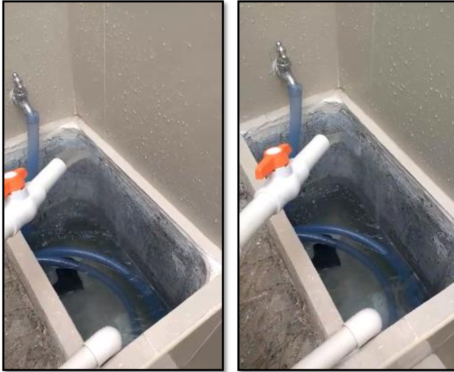
Figura 3-20. Ensayo del sistema de bombeo. Fuente: Autores.
