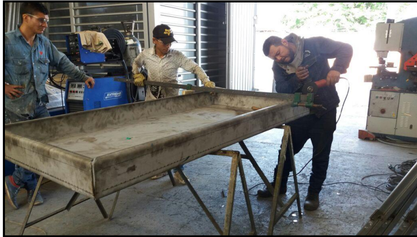
Figura 3-34 Puliendo aristas del tanque de arena. Fuente: Autores.
