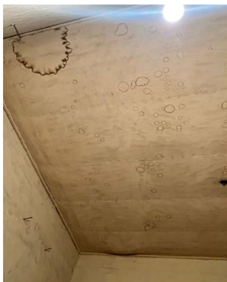
Ilustración 6. Patologías de la cubierta. Fuente: Propia
