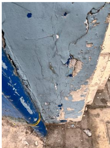
Ilustración 17. Patología mecánica. Fuente: Propia
