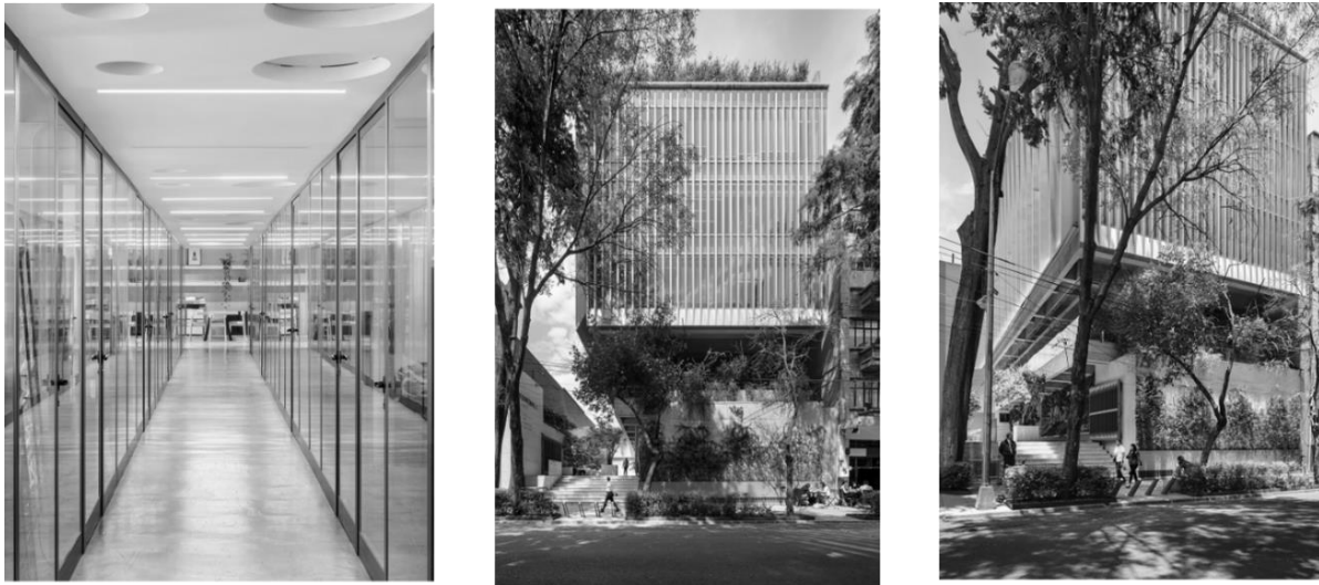
Figura 4. Fachadas y espacio interior de oficinas
