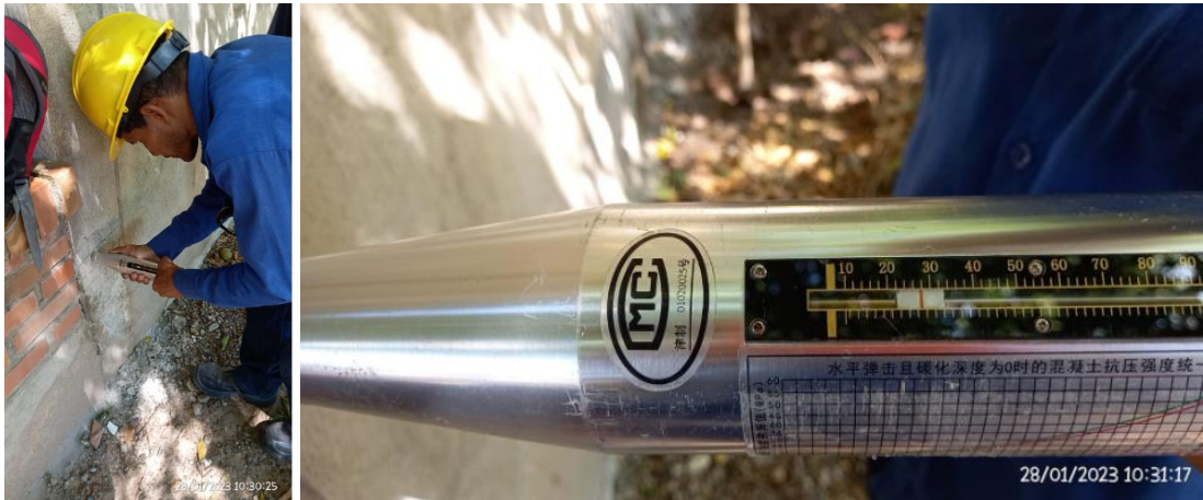
Figura 7. Ejecución Pruebas de esclerometría Columneta Eje 1H
