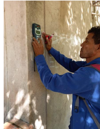
Figura 3. Detección de acero en Columneta 1H
