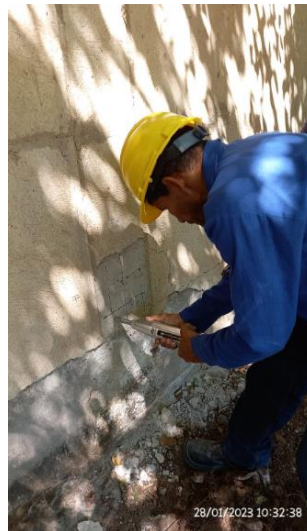
Figura 8. Ejecución Pruebas de esclerometría Columneta Eje 2H
