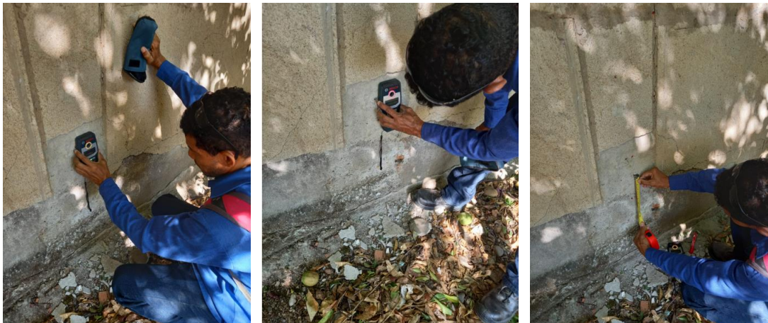
Figura 4. Detección de acero en Columneta 3H
