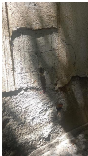
Figura 9. Aplicación prueba con fenolftaleína Columneta 2H
