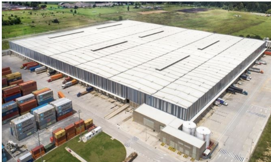
Figura 4. Fachada del Centro de Distribución Funza.
