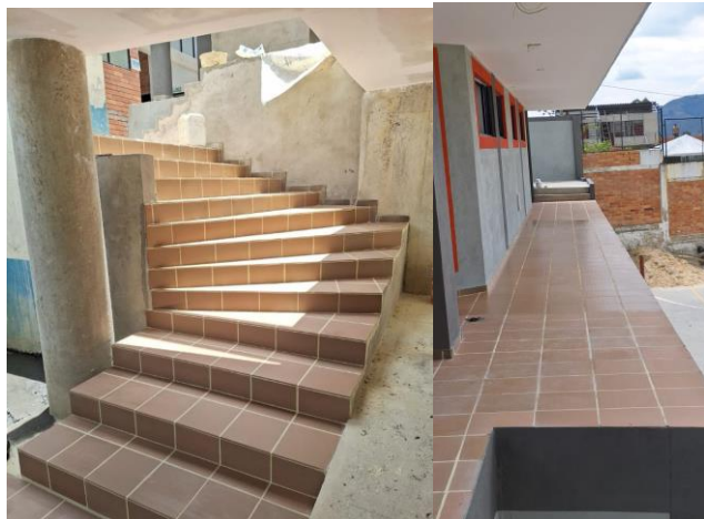
Figura 9. instalación de piso tablón de gres 30*30 cm
