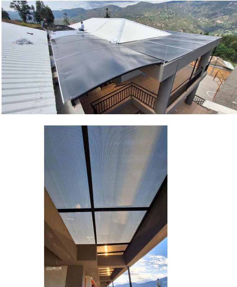
Figura 8. Instalación de estructura metálica y laminas en policarbonato
