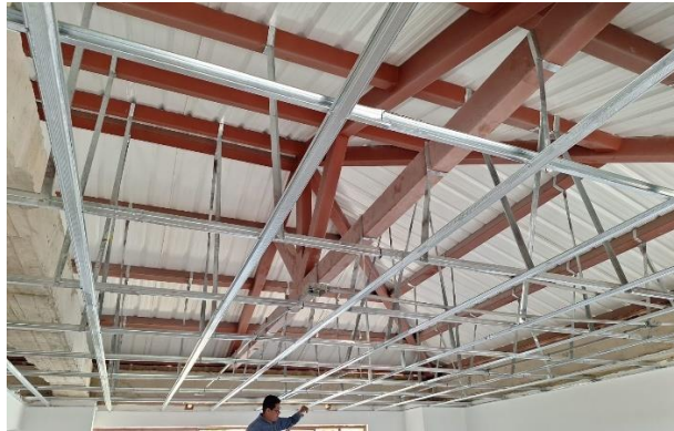
Figura 7. Instalación de estructura metálica y láminas de drywall
