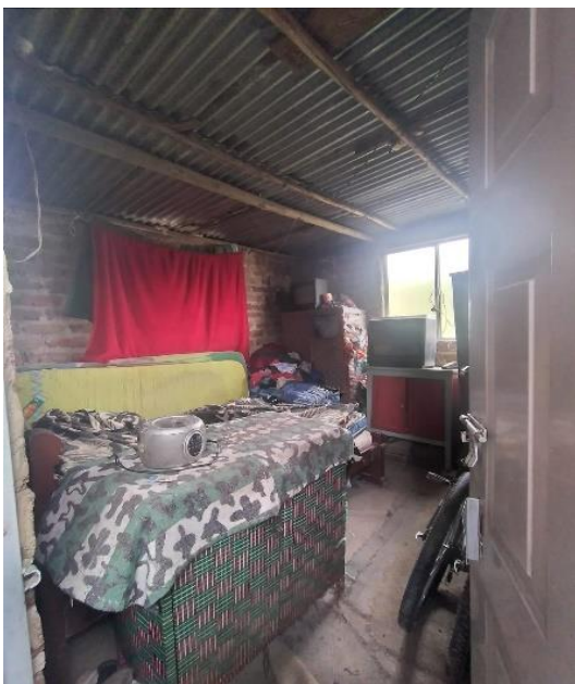
Figura 48. Habitación y Cubierta Vivienda.
