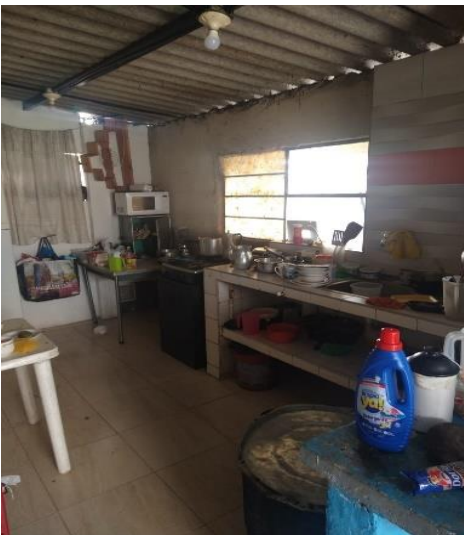
Figura 7. Cocina , cubierta Eternit buen estado de la Vivienda.
