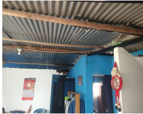
Figura 6. Cubierta teja de Zinc
