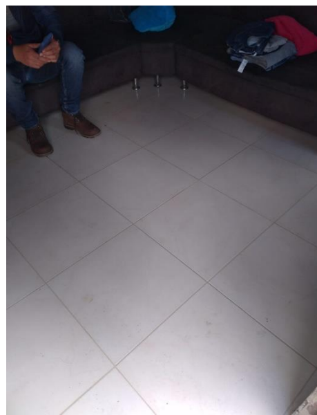
figura 113 . sala comedor piso terminado.
