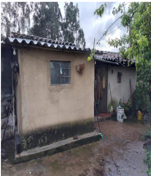
Figura 9 . Fachada y Cubierta Vivienda.
