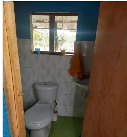
Figura 8. Baño vivienda Buen estado.
