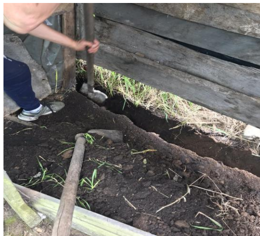
Imagen 27 Adecuación del suelo dentro de la Cabaña Fuente: Autores
