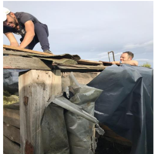
Imagen 29 Exterior de la Cabaña con aislante
