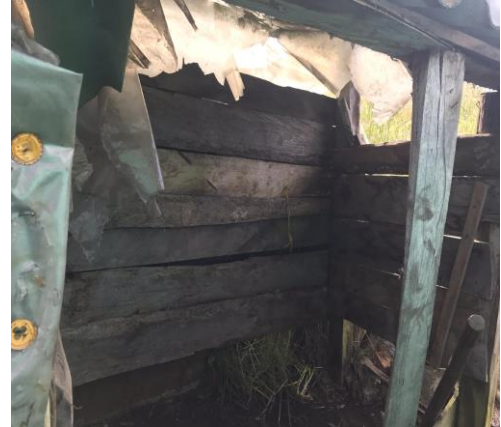
Imagen 26 Interior de la Cabaña Antes
