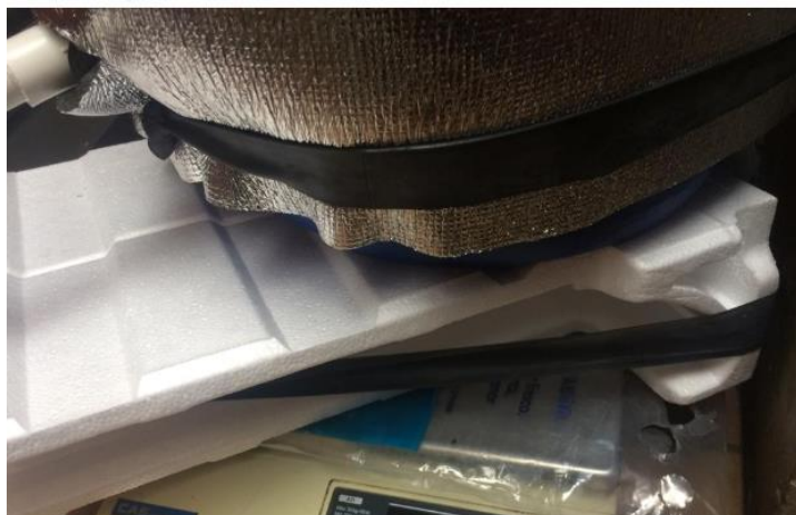
Imagen 43 Enchaquetando biodigestor. Fuente: Autores.
