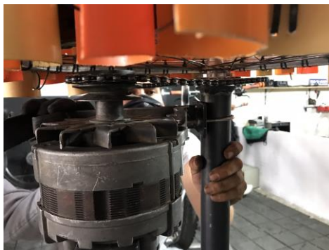
Imagen 25 Instalación completa de Aerogenerador con Alternador y cadena. Fuente: Autores
