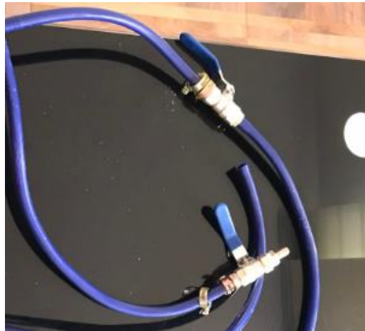
Imagen 36 Ensamble parte biogás. Fuente: Autores.
