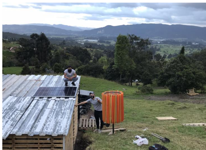
Imagen 52 Instalación del Sistema Híbrido en la vivienda Fuente: Autores
