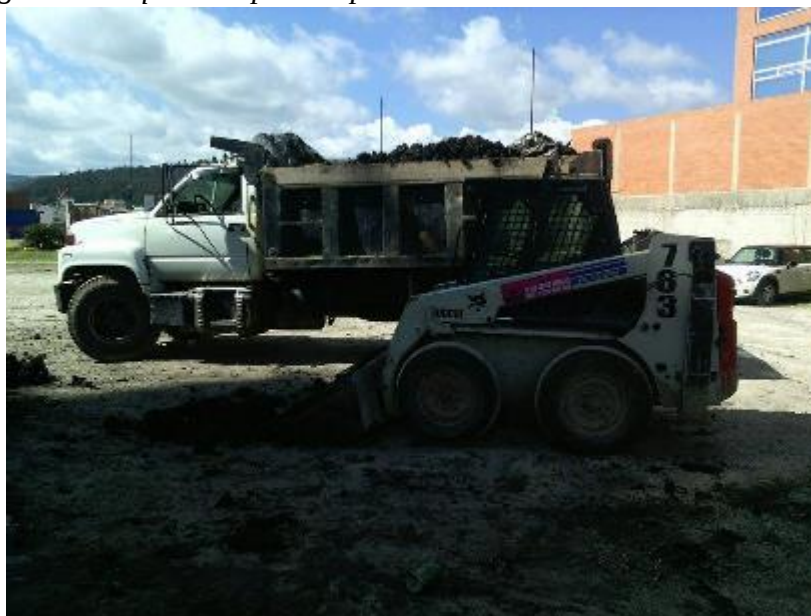
Figura 3 Maquinaria pesada para retiro de escombros
