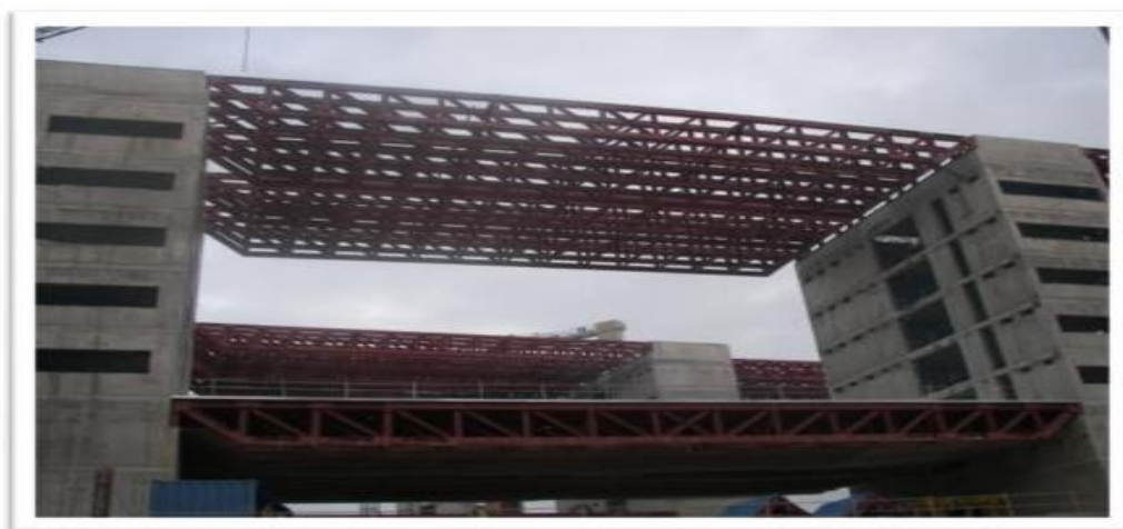
Figura 13. Etapa de construcción Hospital de Toledo
