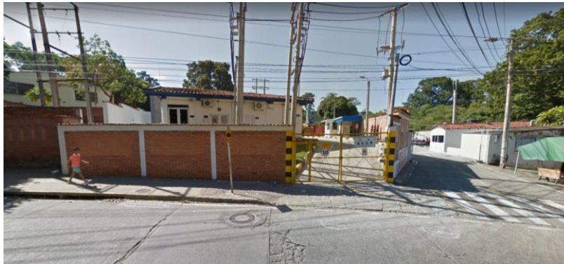
Figura 40. Estación de bomberos
