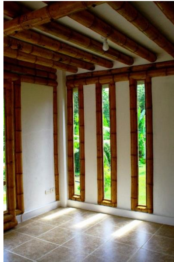
IMAGEN 10 Construcción en guadua
