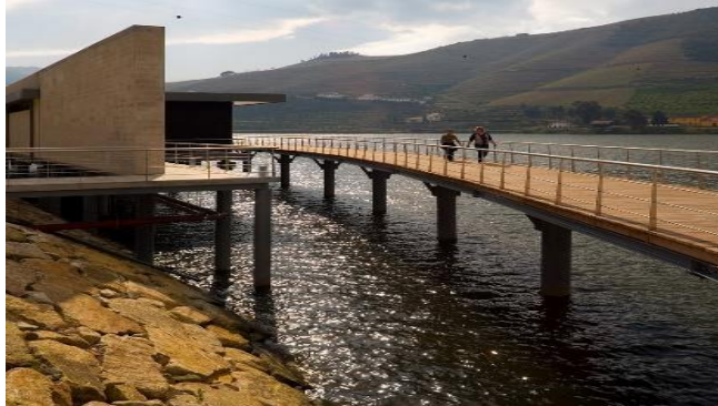
Figura 27. Vista al muelle de Folgasa.
