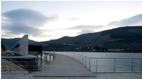
Figura 38. Acabado exterior del muelle
