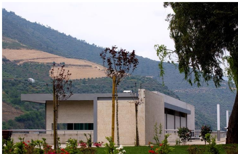
Figura 32. Vista exterior del muelle de Folgasa
