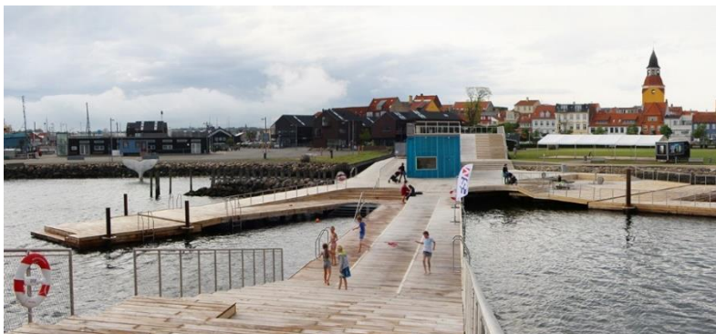
Figura 26. Exteriores del muelle de Folgasa
