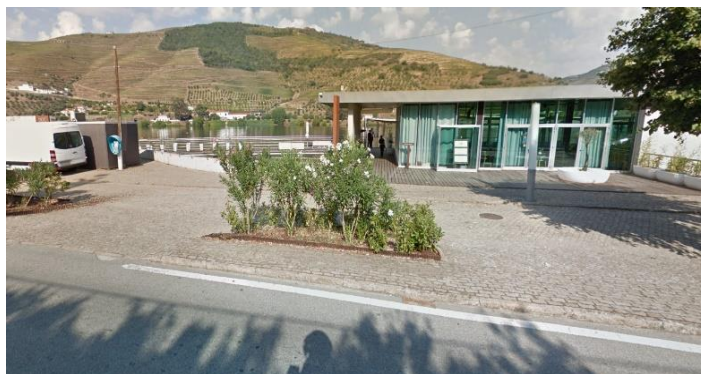
Figura 34. Fachada exterior del proyecto (Norte) Muelle de Folgasa
