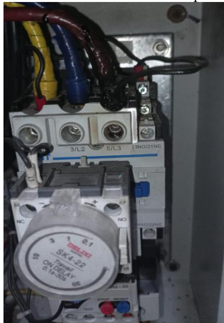
Figura 8. Cambio de componentes del tablero eléctrico del compresor
