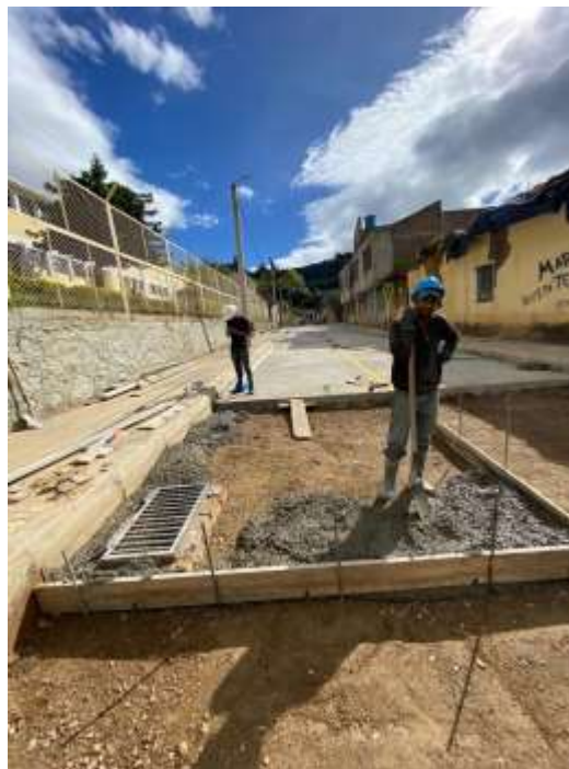
Figura 15. Distribución del encofrado
