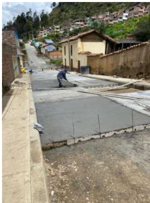
Figura 17. Losas de concreto
