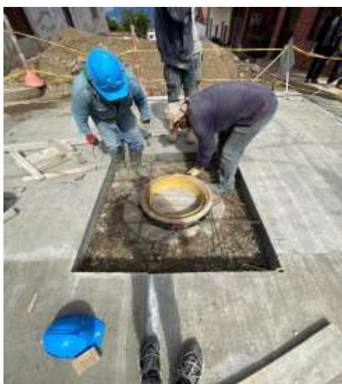
Figura 22. nivelación de pozos
