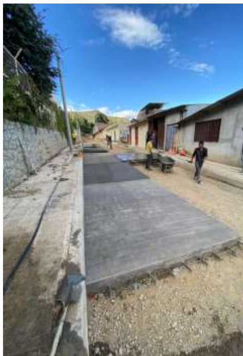
Figura 16. Losas de concreto
