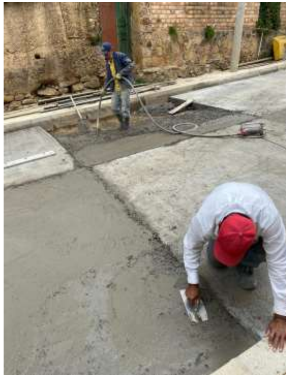
Figura 19. Vibrado del concreto
