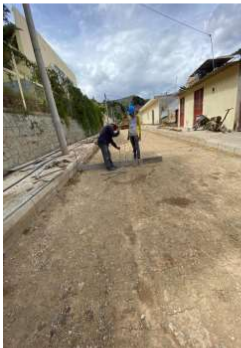
Figura 14. Distribución del encofrado
