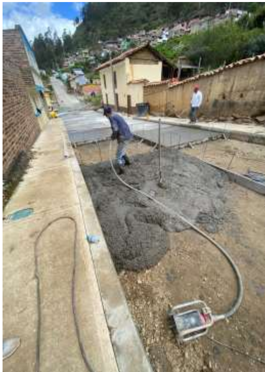
Figura 18. Vibrado del concreto
