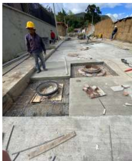
Figura 23. nivelación de pozos
