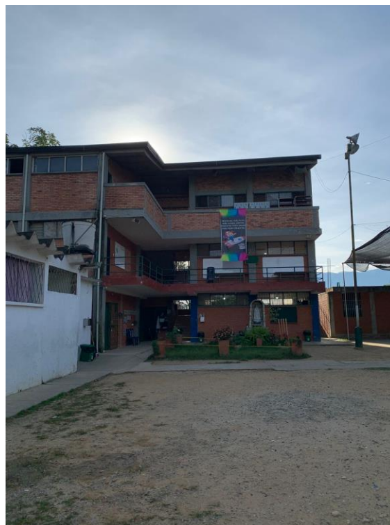
Figura 11. Instalaciones aulas y administración
