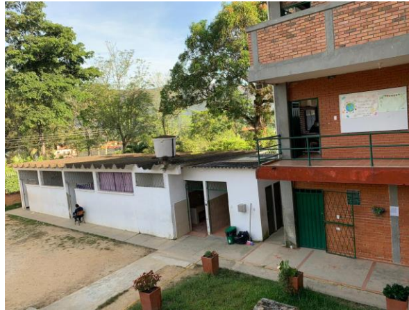
Figura 12. Instalaciones aulas y baños
