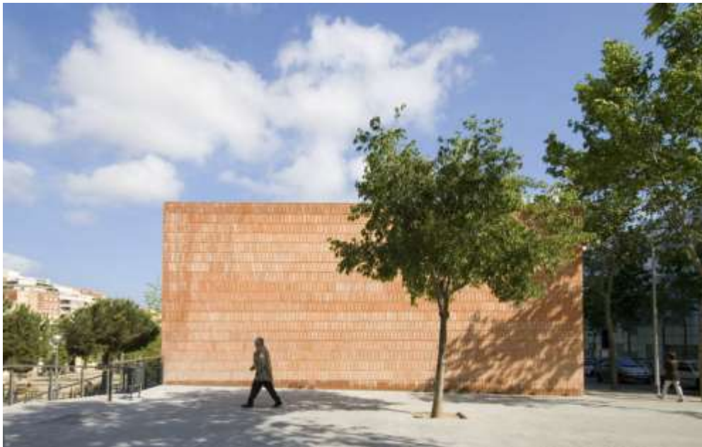
Figura 21. Casa para la tercera edad / BCQ Arquitectes
