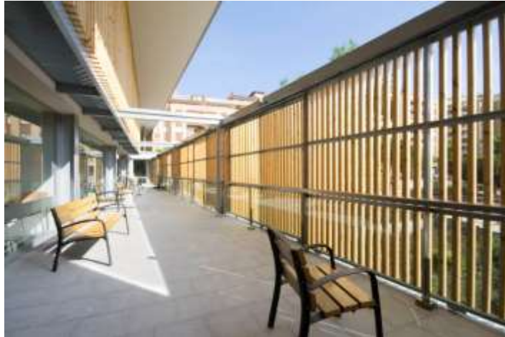
Figura 23. Casa Para La Tercera Edad / BCQ Arquitectes
