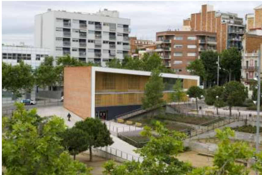
Figura 20. Casa Para La Tercera Edad / BCQ Arquitectes
