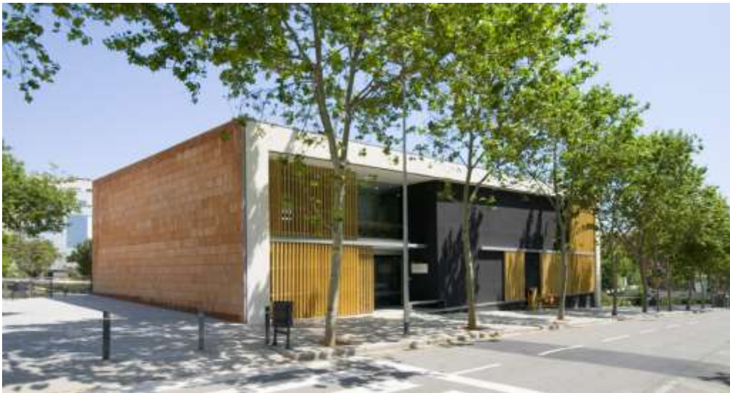
Figura 22. Casa Para La Tercera Edad / BCQ Arquitectes
