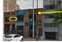
CALLE DE EMPALME UNICADA EN LA CLASE CON CARRA
