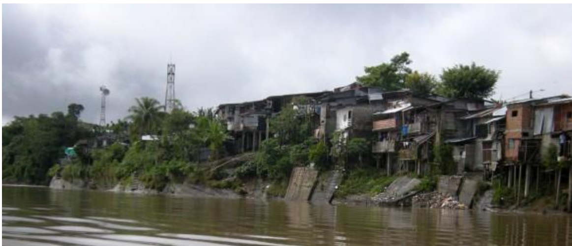
Figura 17: Viviendas del municipio de Lloró sobre el río Atrato – Recuperado en: http://news.beoo.com/the-wettest-place-on-earth/
