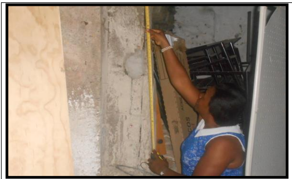
MEDICIÓN DE ELEMENTO DETERIORADO
