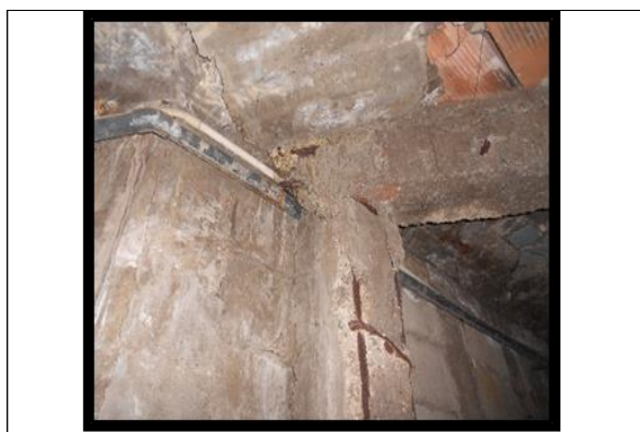
LESION EN COLUMNA Y VIGAS DEL MURO DE CONTENCIÓN (DESPRENDIMIENTO DEL CONCRETO, OXIDACIÓN, CORROSIÓN)
