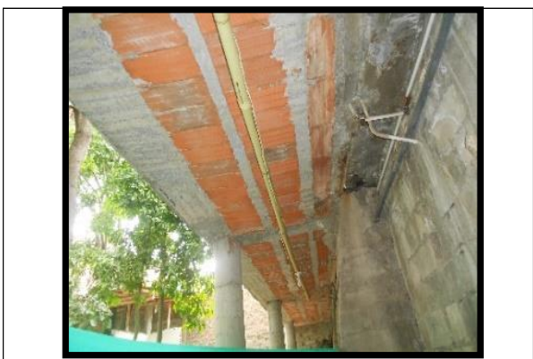
HUMEDAD EN LA PLAYA DE LA PISCINA QUE AFECTA EL MURO DE CONTENCIÓN
