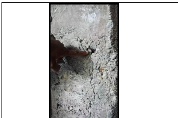
FISURA EN MURO DE CONTENCIÓN
