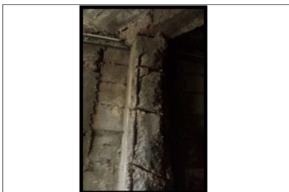
LESION EN COLUMNA Y VIGAS DEL MURO DE CONTENCIÓN (DESPRENDIMIENTO DEL CONCRETO, OXIDACIÓN, CORROSIÓN)
