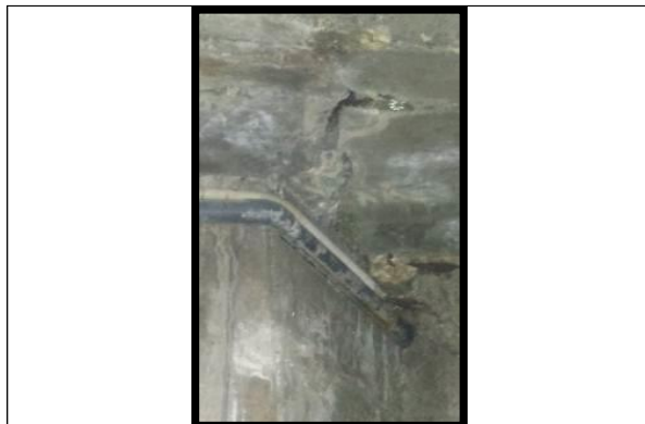
EFLORESCENCIA EN MURO DE CONTENCIÓN
