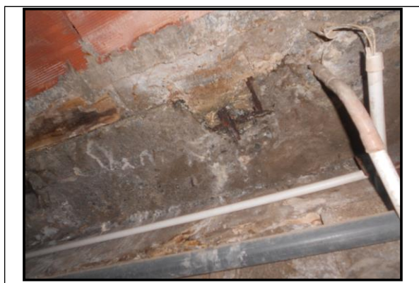
HUMEDAD EN LA PLAYA DE LA PISCINA QUE AFECTA EL MURO DE CONTENCIÓN
