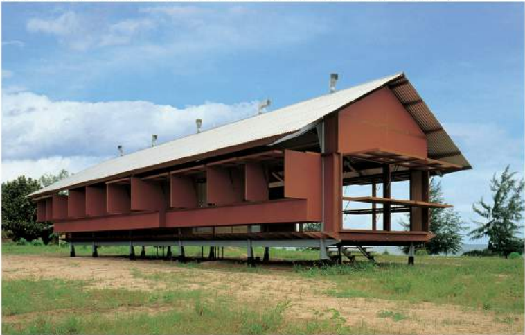
FIGURA 31. Fotografía Perspectiva exterior. Murcutt. G. (1994).
