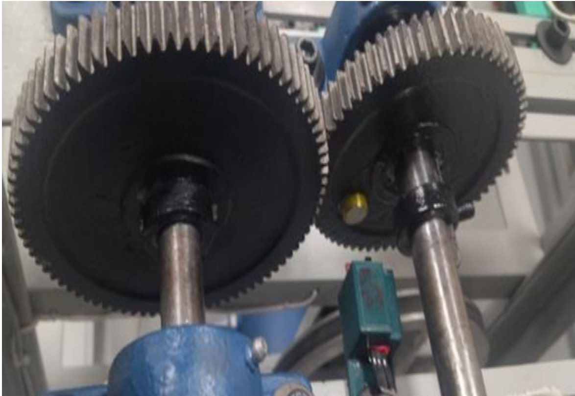
Figura 31. Engranajes Rectos de la Etapa 4 y Etapa 5 con su pintura de protección color negro.
