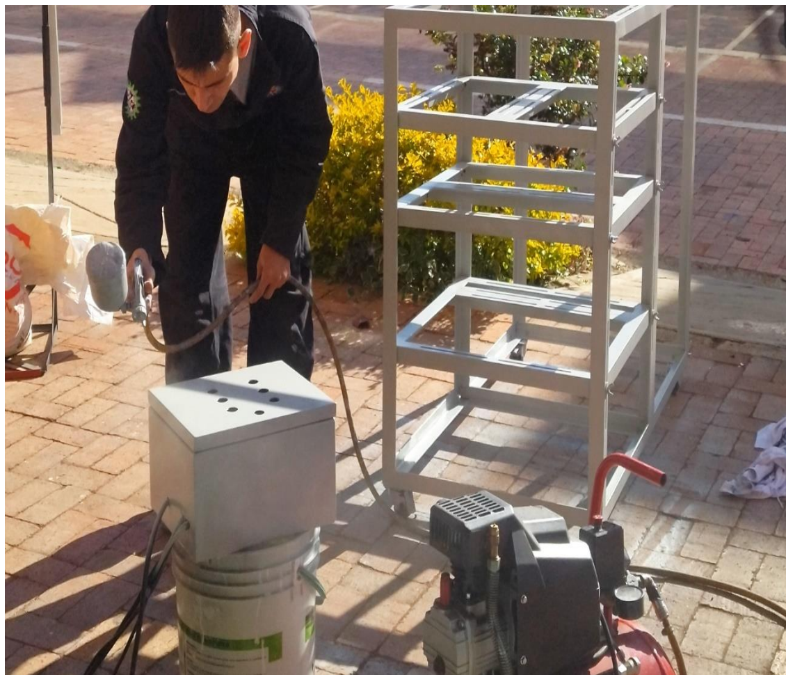
Figura 37. Preparación y pintura de la Caja de control.
