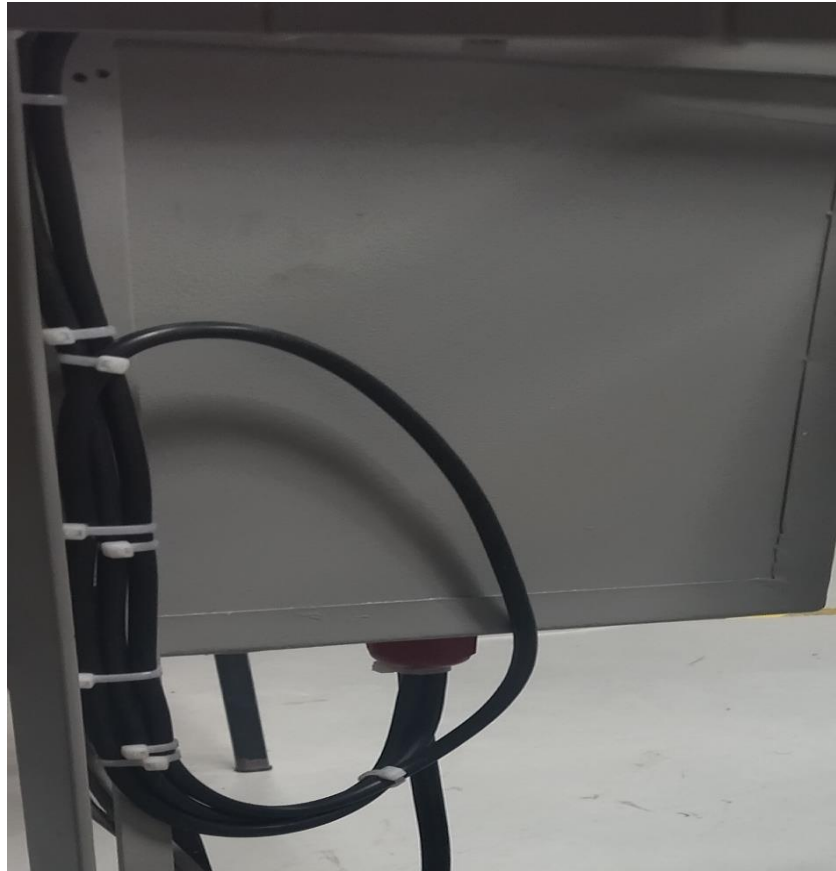
Figura 43. Sujeción de los cables para la conexión de los sensores fin de carrera a la estructura.
