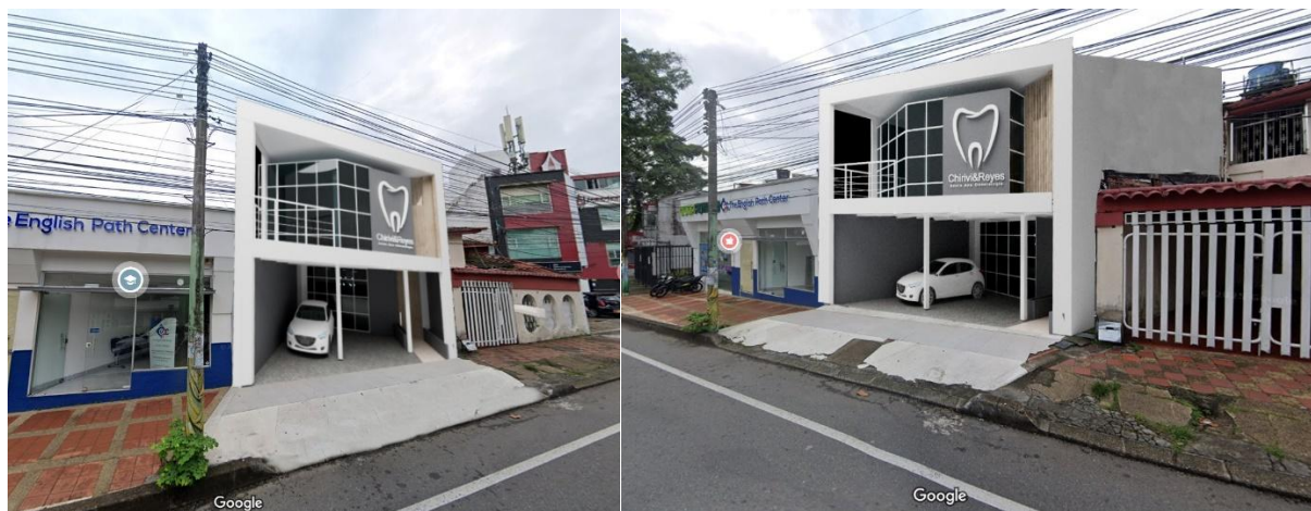
Figura 4. Fachada del proyecto
