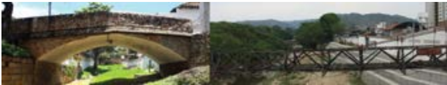
Figura 13. Izq. Puente de Calicanto Antón García. Derecha vista de la pasarela barajas
