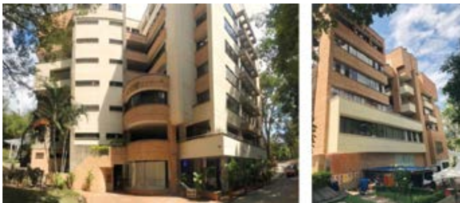
Figura 27. Fachada occidente y oriente Edificio Fray Angélico, abril de 2018
