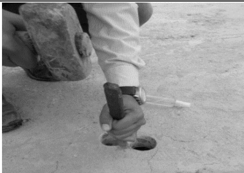
Figura 29: Escarificación previa al roció de fenolftaleína en la placa de parquetado. Fuente: Los autores
