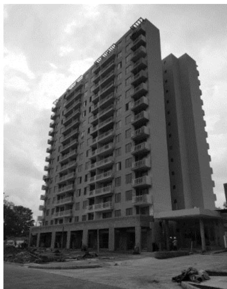
Figura 2: Progreso de la obra.
