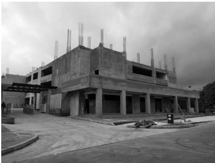
Figura 3: Fachada de la construcción Santafé de Varsovia. Fuente: Autores.
