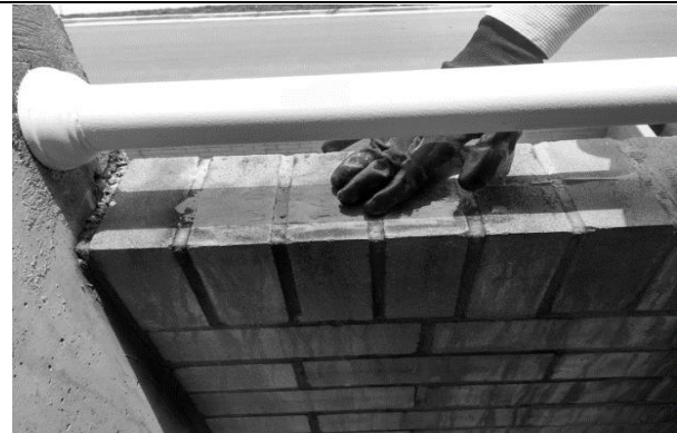
Figura 559: Aplicación del producto limpiador. Fuente: Los autores
