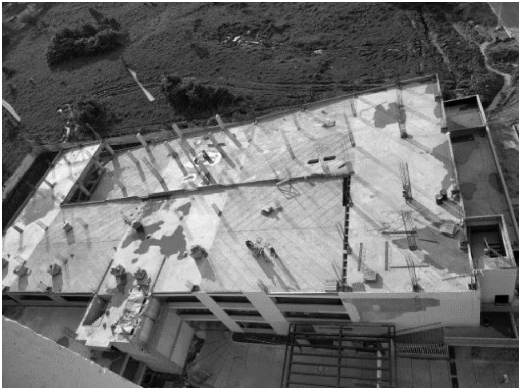
Figura 4: Vista aérea del edificio de parqueaderos. Fuente: Autores.
