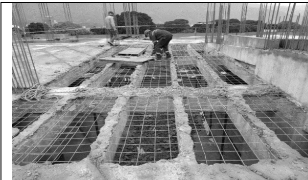
Figura 464: Terapéutica en la lesión sobre el edificio de parqueadero. Fuente: Los autores
