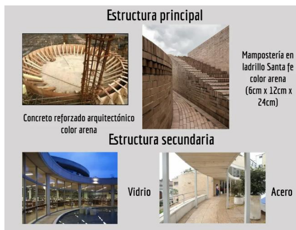
Figura 15. Material, sistema constructivo y modulación
