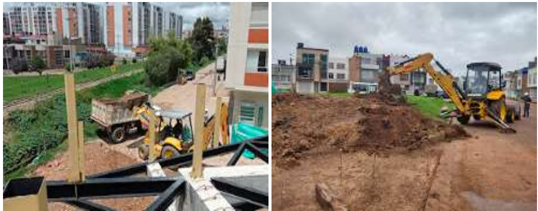
Fig. 28. Extracción de material orgánico.
