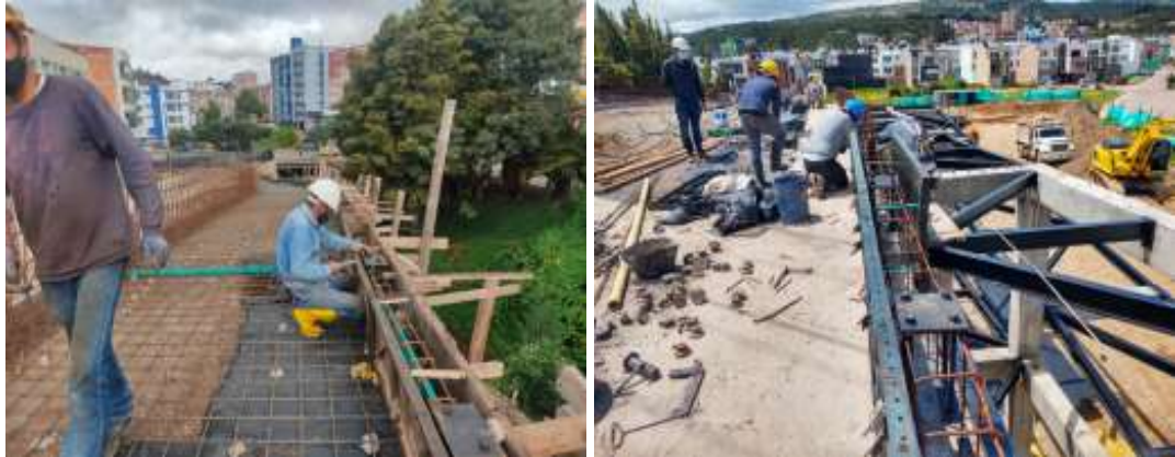
Fig. 12. Instalación de anclajes para baranda.
