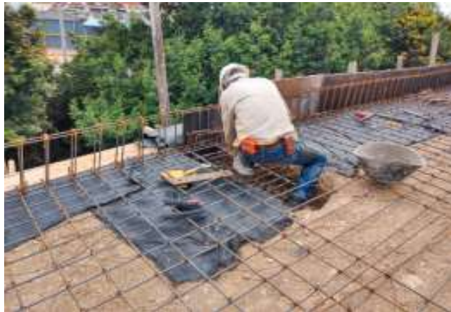
Fig. 9. Instalación de anclaje para poste en bordillo norte.
