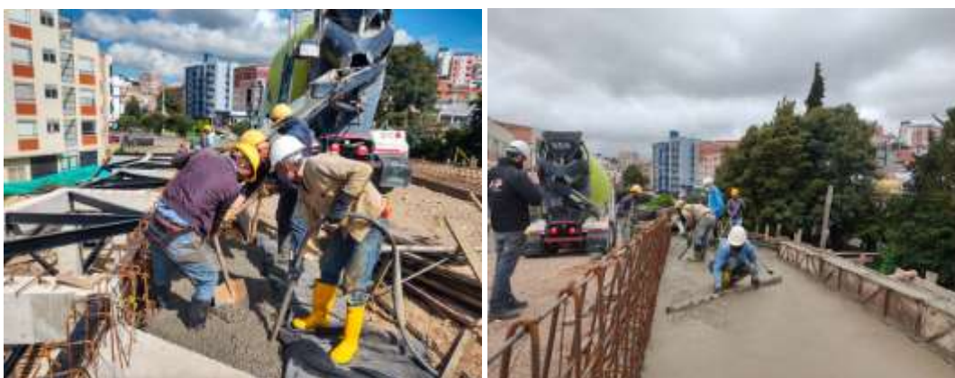
Fig. 16. Vaciado de Concreto.
