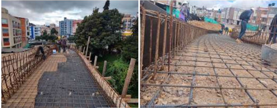
Fig. 25. Armado de Parrillas.
