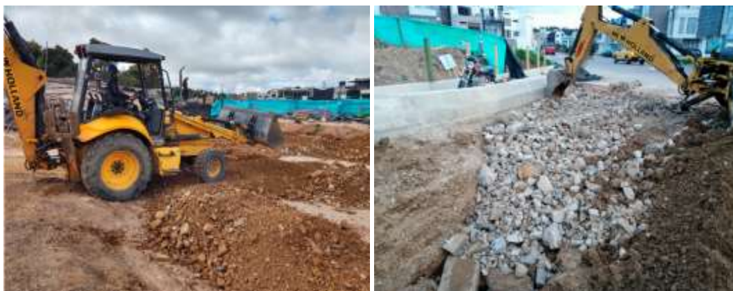
Fig. 24. Compactación en empalme con barrio las Quintas.
