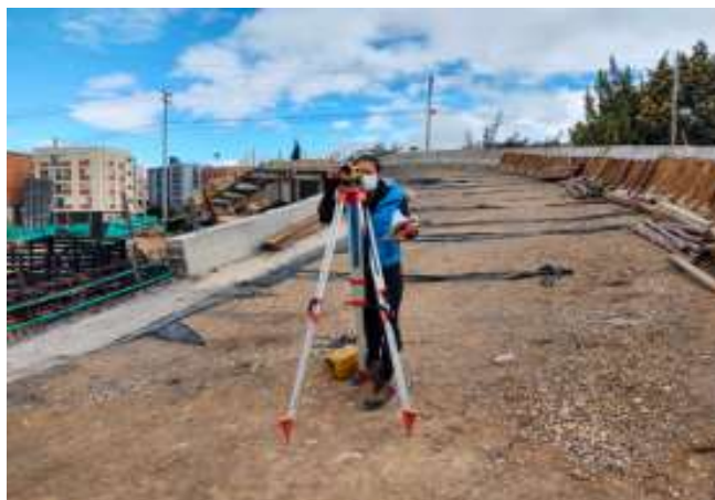
Fig. 10. Toma de niveles por medio de nivel de precisión.
