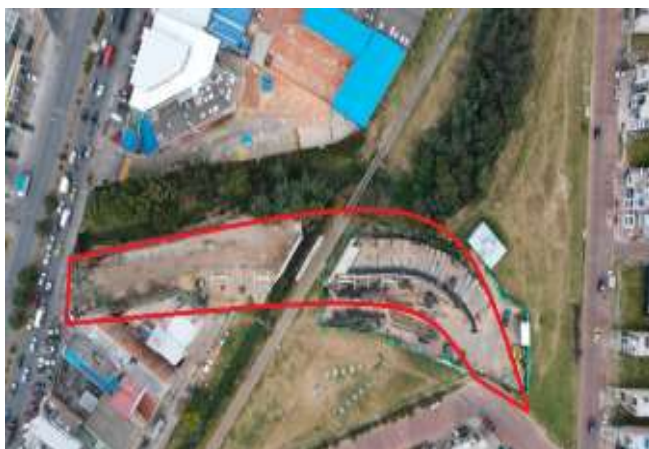
Fig. 2. Puente vehicular en construcción.
