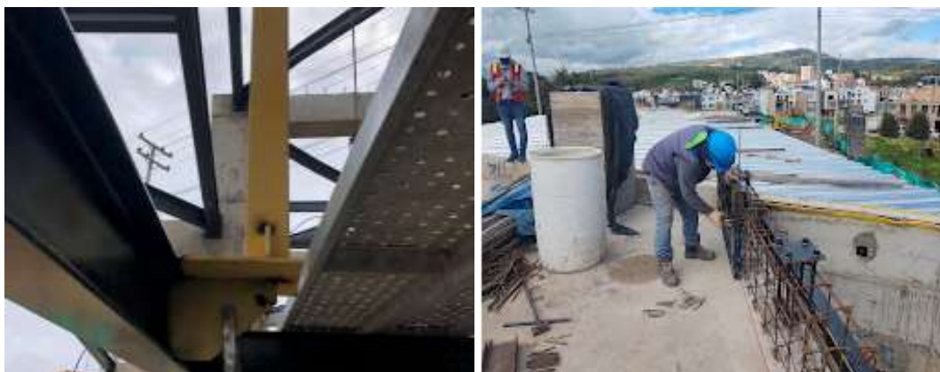
Fig. 23. Instalación de anclajes de rampas y bordillos.
