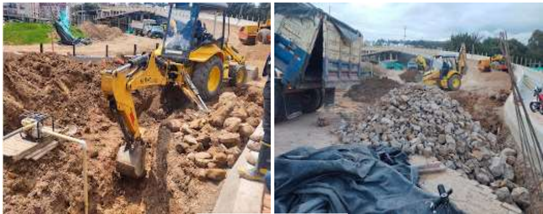
Fig. 31. Mejoramiento con pedraplén.
