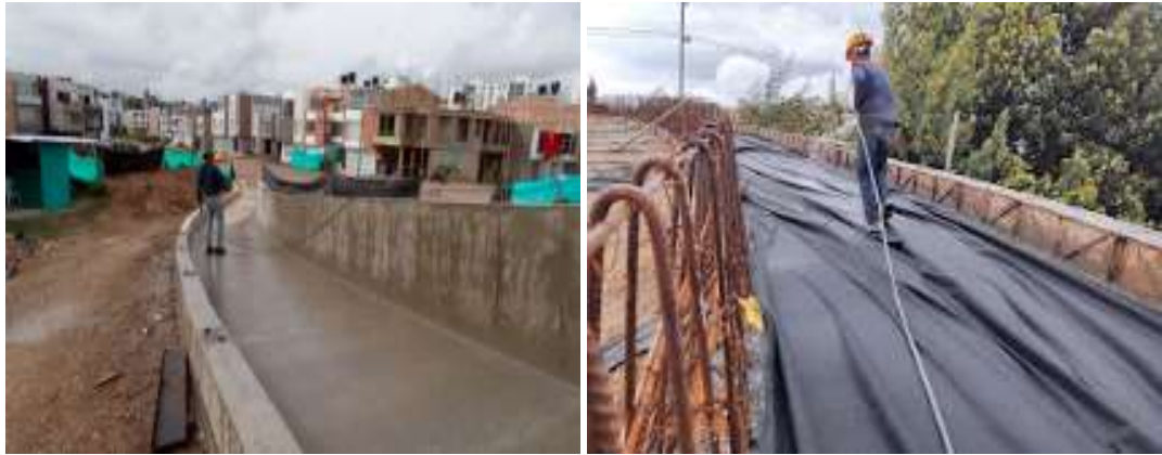
Fig. 18. Curado en concretos fundidos.
