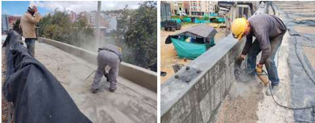
Fig. 20. Construcción de juntas en concretos.
