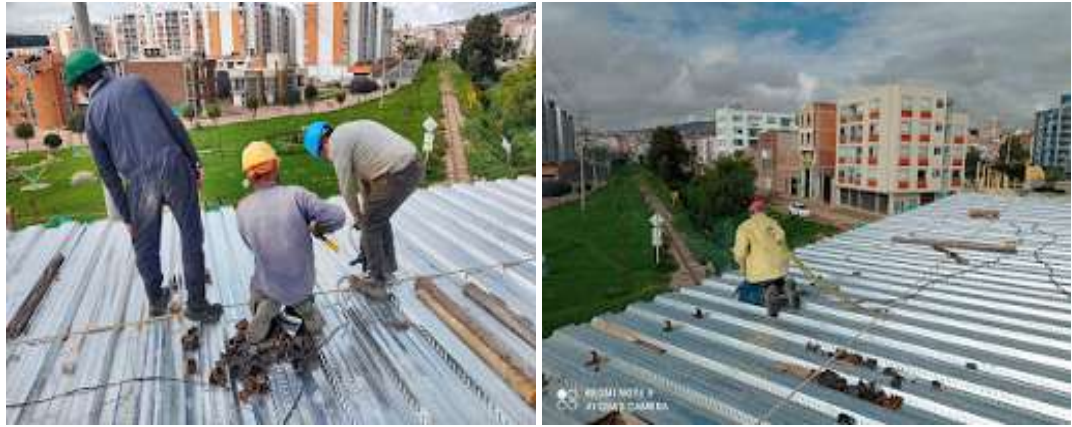
Fig. 27. Instalación de Steel deck y conectores de cortante.
